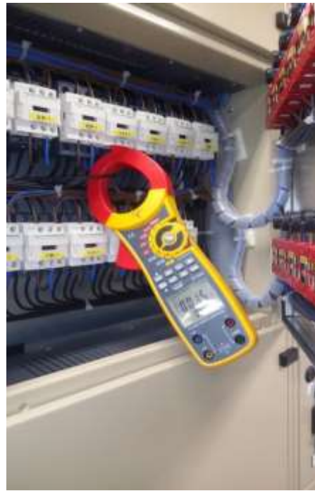
KUVA 8. IV-ryhmäkeskuksen sähkötehon mittaus KUVA 9. IV-koneen sähkötehonmittaus (kuva: Heikki Loukusa 20.1.2017)
