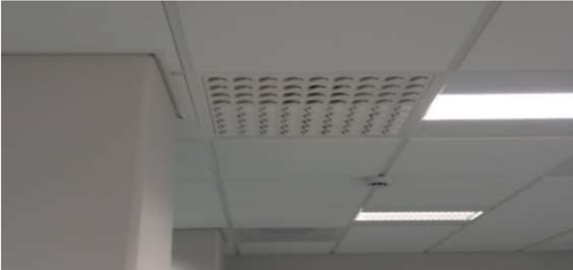
Kuva 23. Tuloilmapäätelaite suunnattuna savukokeen jälkeen (kuva: Heikki Loukusa 12.12.2016)
