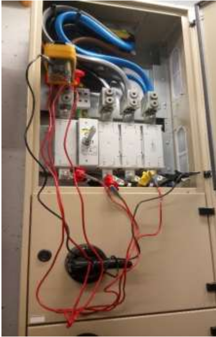
KUVA 8. IV-ryhmäkeskuksen sähkötehon mittaus KUVA 9. IV-koneen sähkötehonmittaus (kuva: Heikki Loukusa 20.1.2017)
