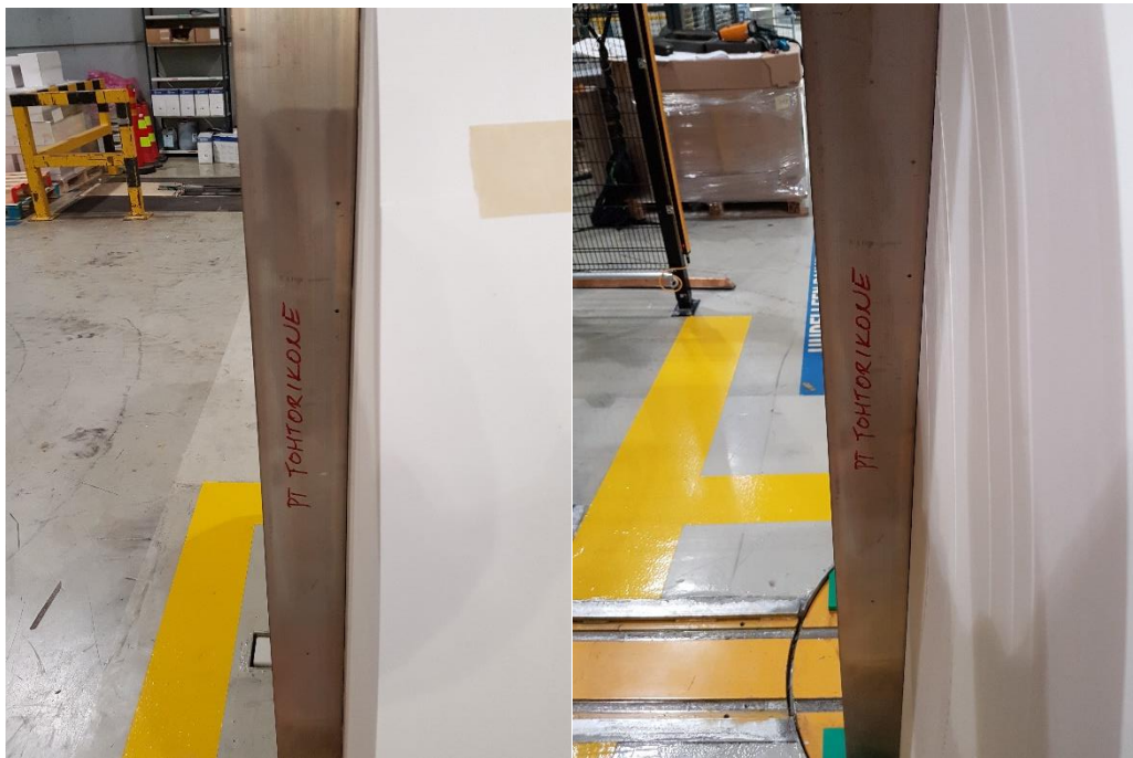
Patapäisyys heittojen korjauksen jälkeen
