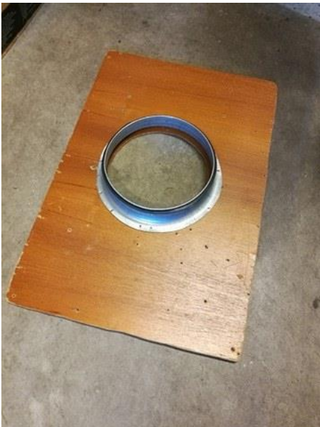
KUVA 10. Itse tehty adapteri, jonka avulla alipaineistaja voidaan liittää ilmanvaihtokoneen kannen paikalle.
