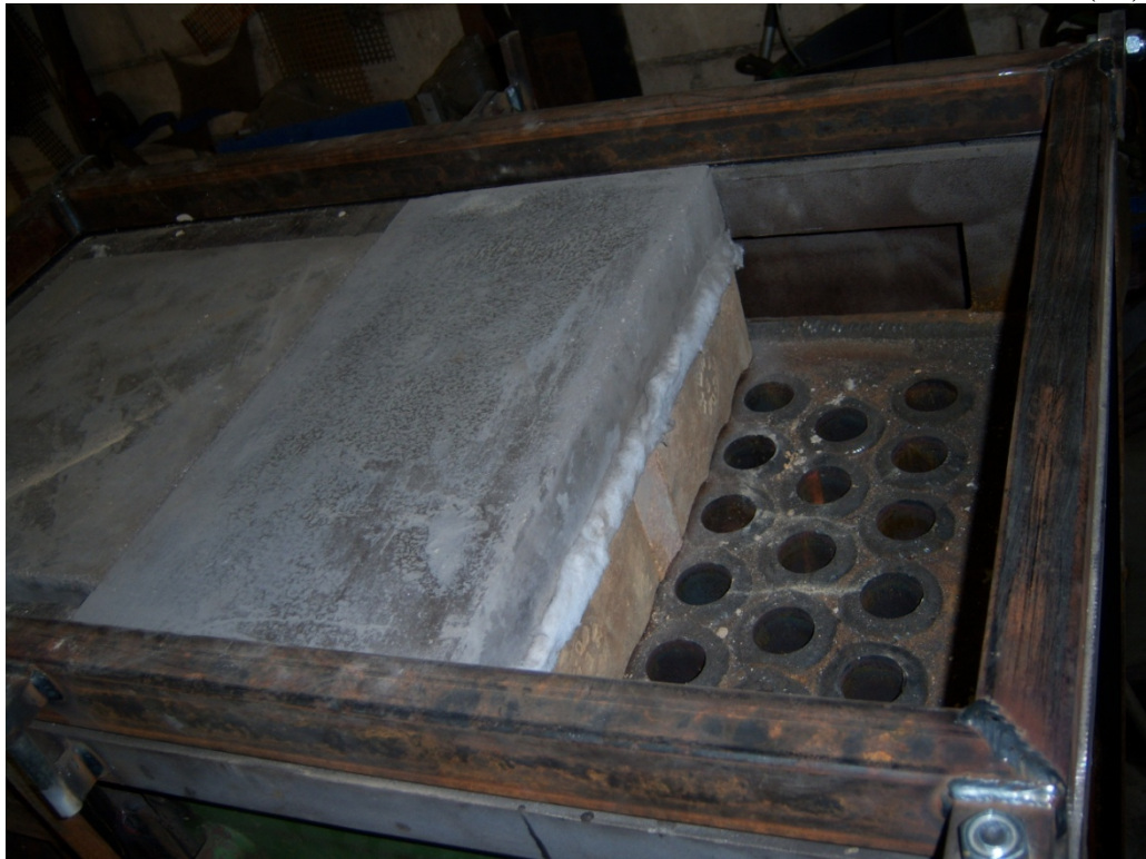
KUVA 5. Kattilan konvektio-osan päällystä
