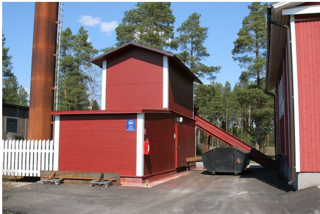
KUVA 1. Helppo Lämpö Oy:n lämpölaitos Ylihärmässä /1/
