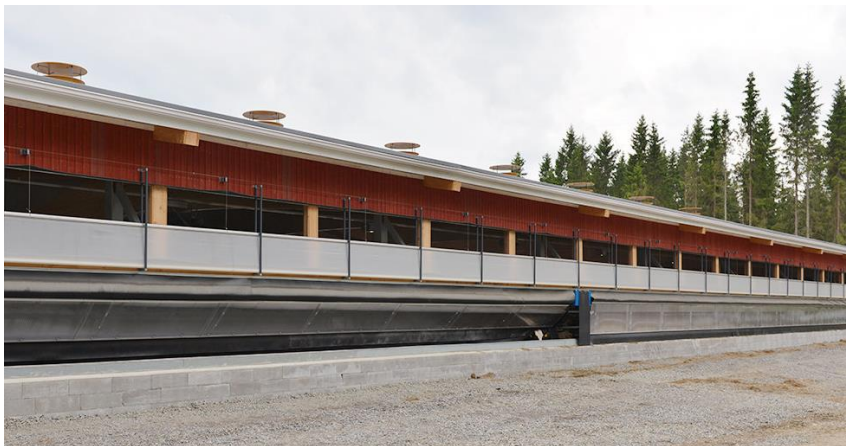
KUVA 7. Verhoseinä aukkojen peittämiseksi ( www.pellon.fi )
