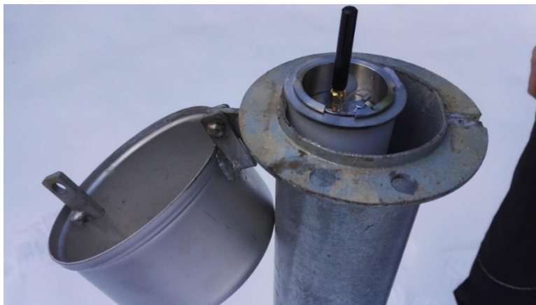
Kuva 10. Mittalaitteisto asennettuna pohjavesiputkeen
