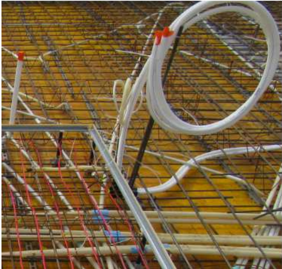
Kuva 10. Vesijohtojen nosto L-raudoilla.
