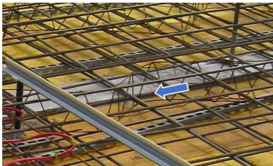
Kuva 5. Väliseinän korko 10 mm yli muottipinnasta.
