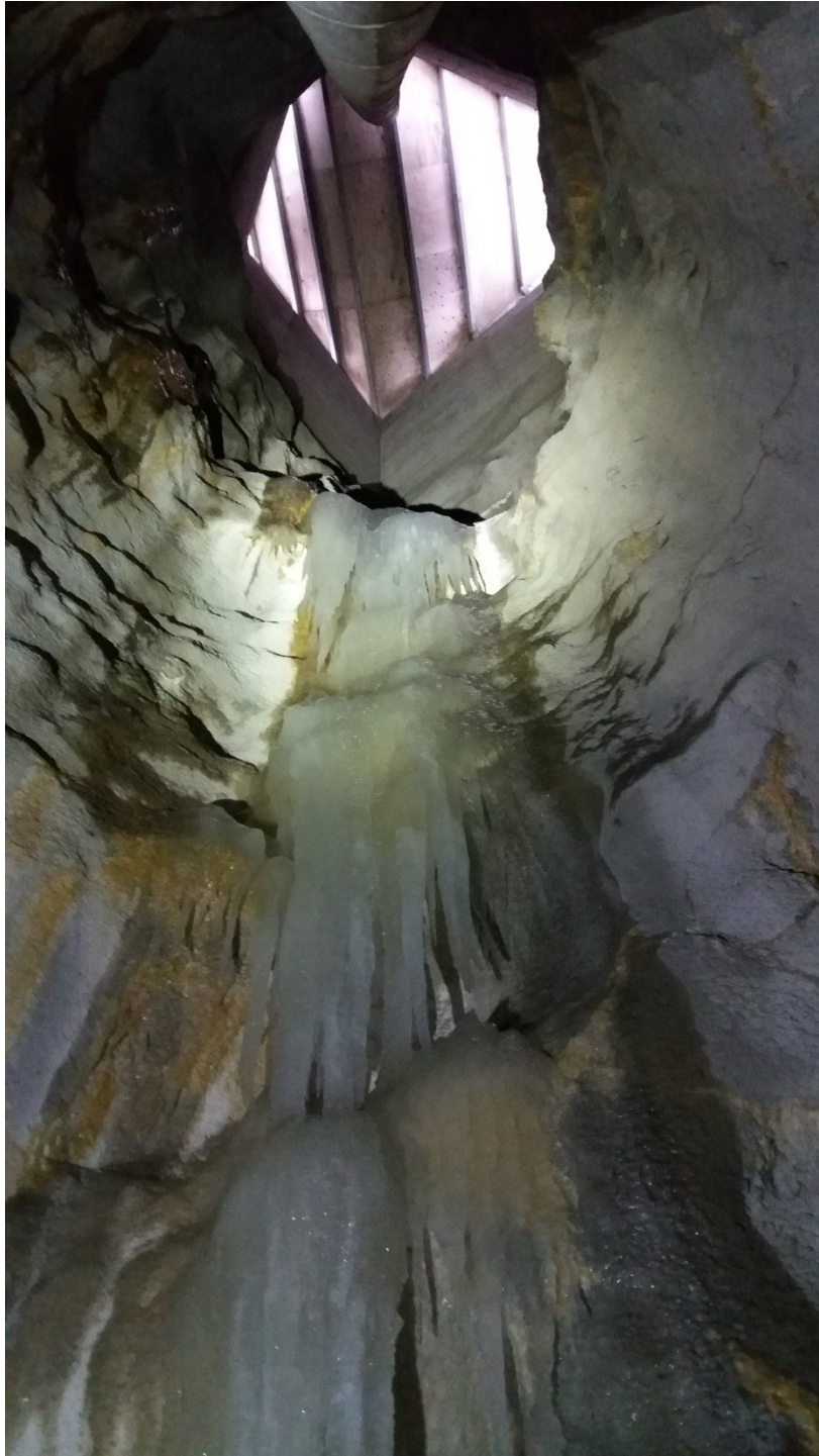
Kuva 33. Maunulan urheiluhallin tuloilmakuilu.
