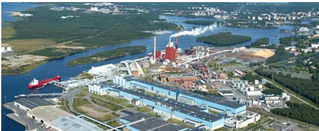
KUVA 1. Stora Enson Oulun tehdas (3)
