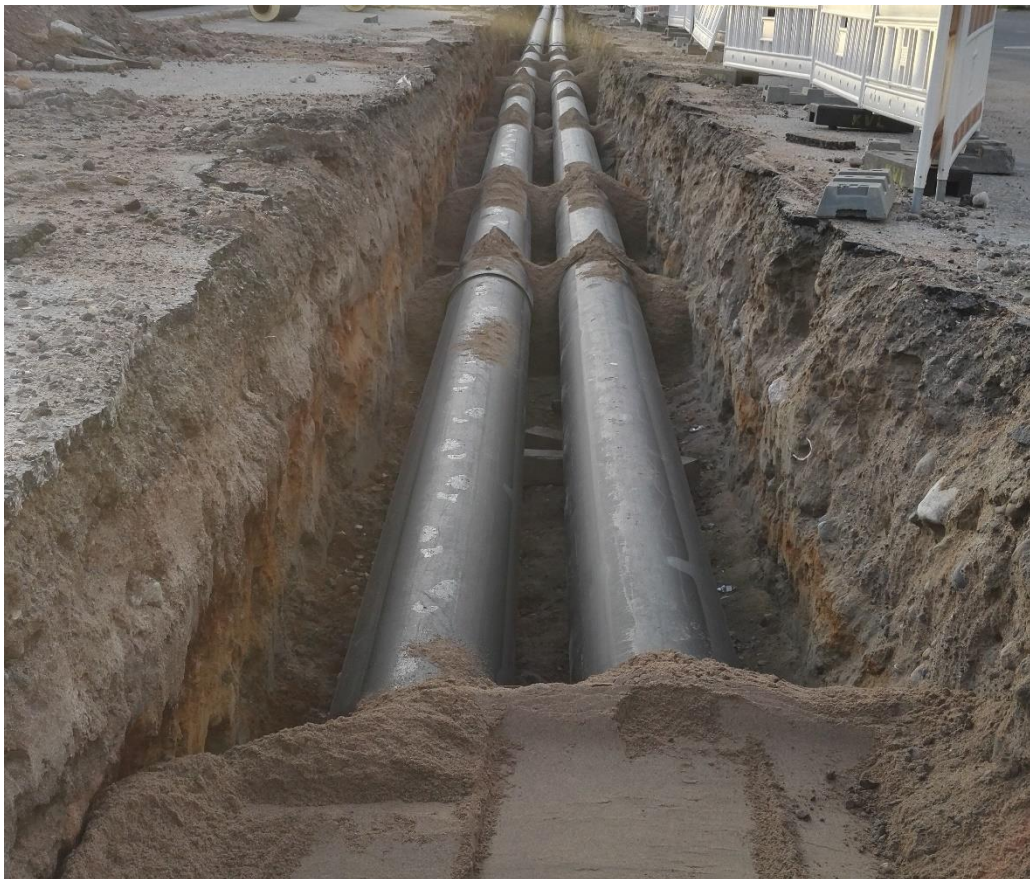
Kuva 12. Hiekkatartuntoja peittotyössä
