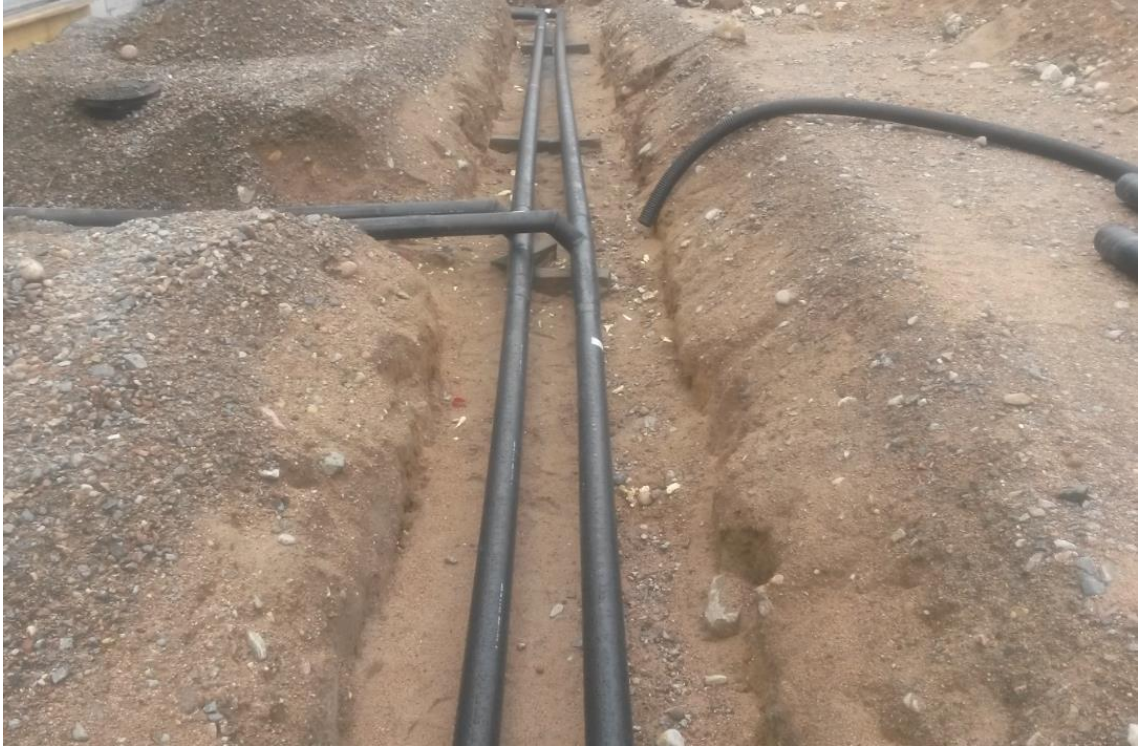
Kuva 3. 2Mpuk asennettuna kaivannossa
