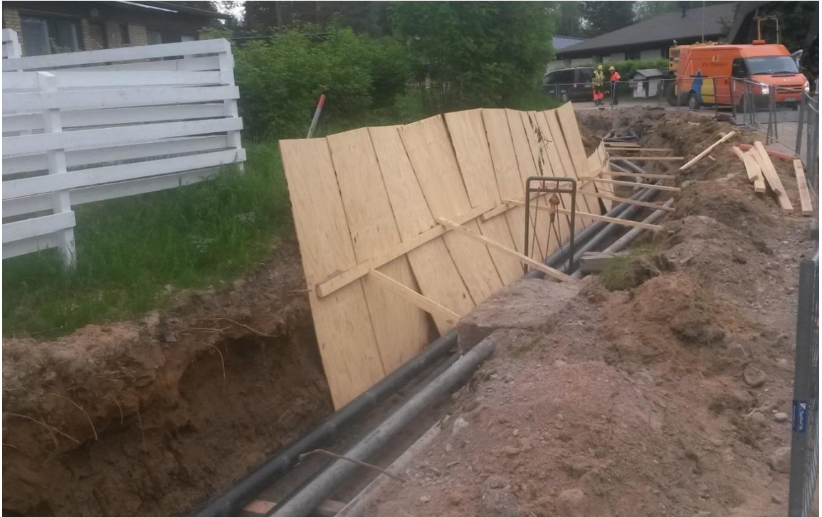
Kuva 10. Kaivannontuenta rakennettu sortumavaaran takia
