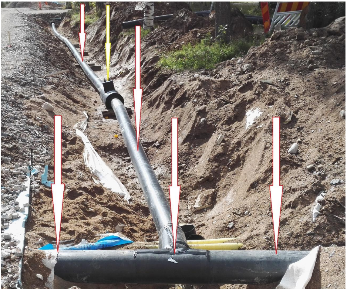
Kuva 14. MPuk-linjan mittauskohdat
