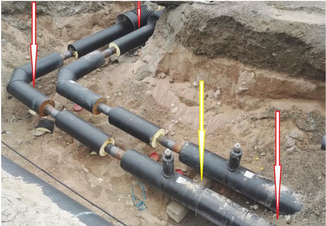
Kuva 15. 2MPuk-linjan mittauskohdat
