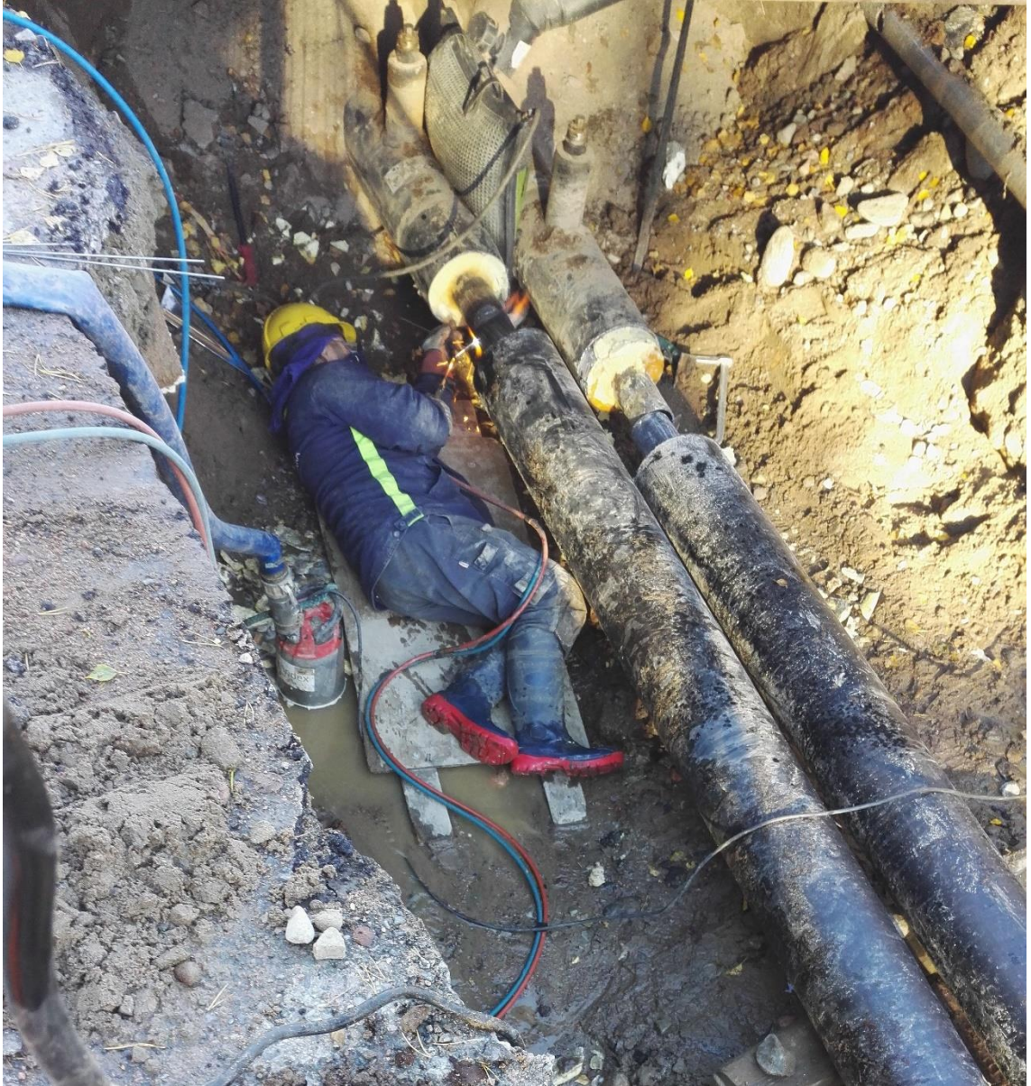
Kuva 11. Hitsaajalle on jätettävä riittävästi työtilaa
