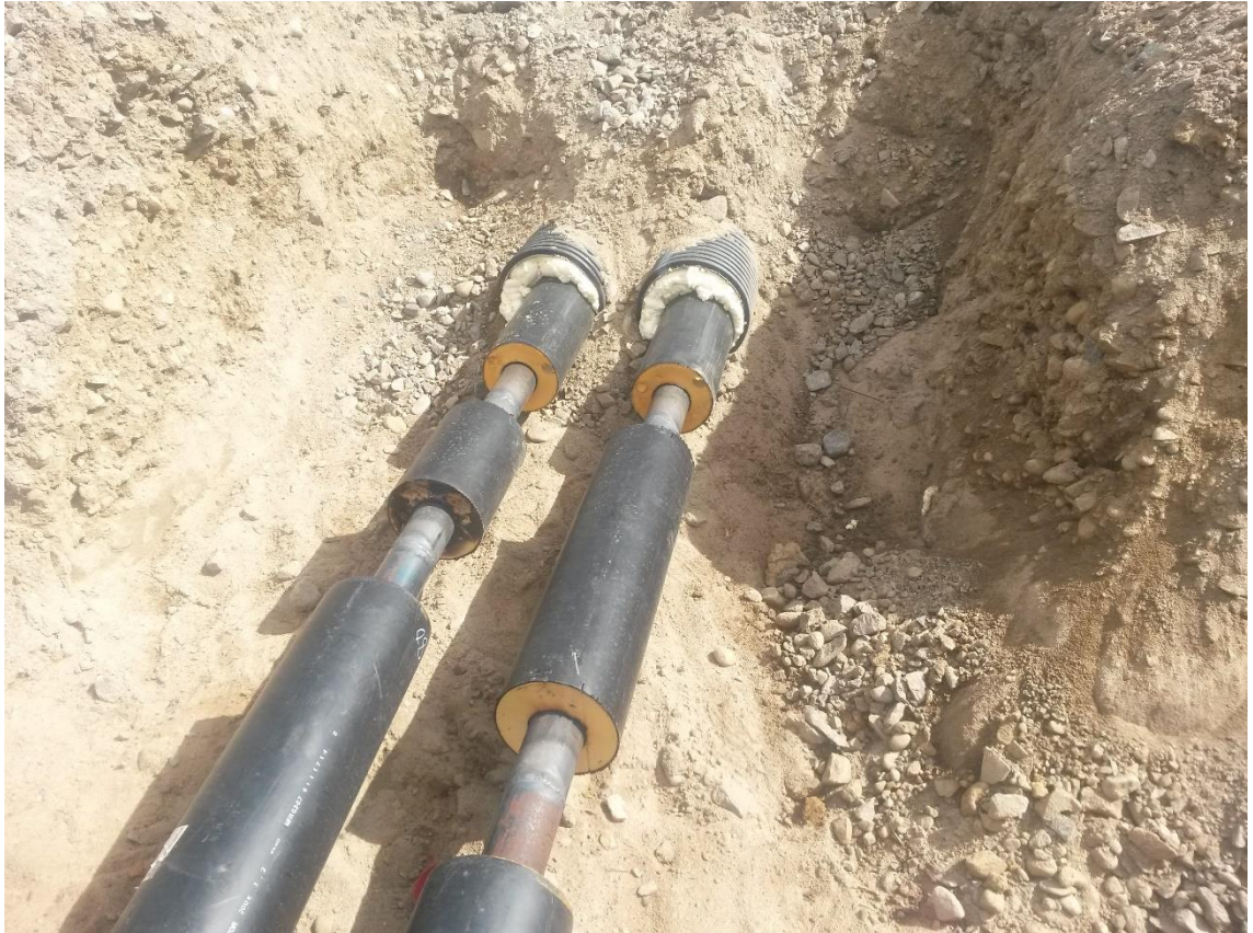
Kuva 9. Tien alitus suoritettu alitusputkia käyttämällä
