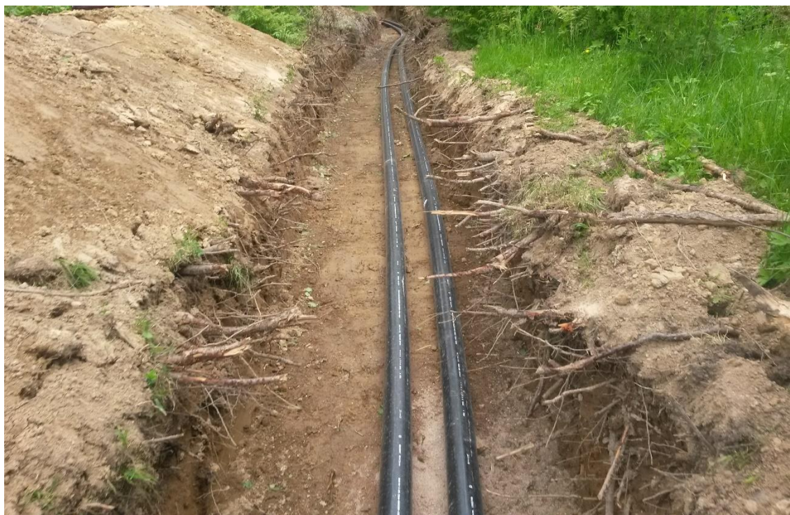
Kuva 2. JOP-putket kaukolämpökaivannossa
