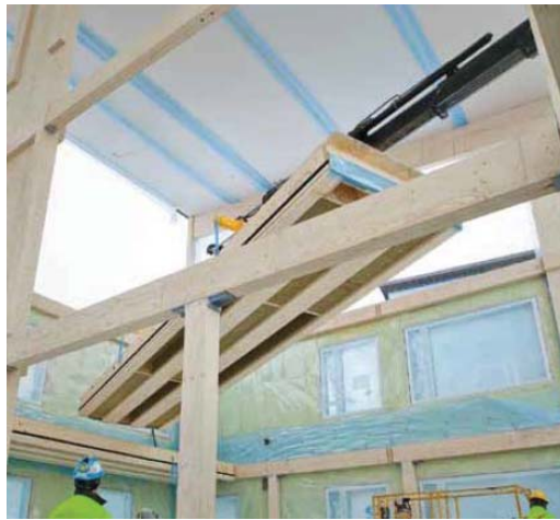
KUVA 17. Välipohjajaelementin asennustyö (Metsä Wood 2013, 10.)
