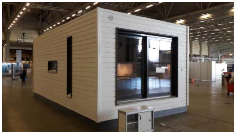
KUVA 11. Tehtaalla valmistettu tilaelementti (Elementti Sampo 2016.)
