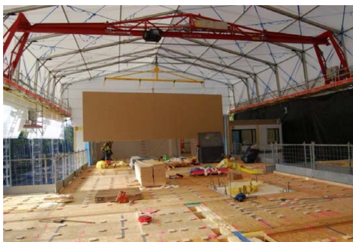
KUVA 34. PuuMeran seinäelementtien asennus työmaalla (PuuMera 2016a.)
