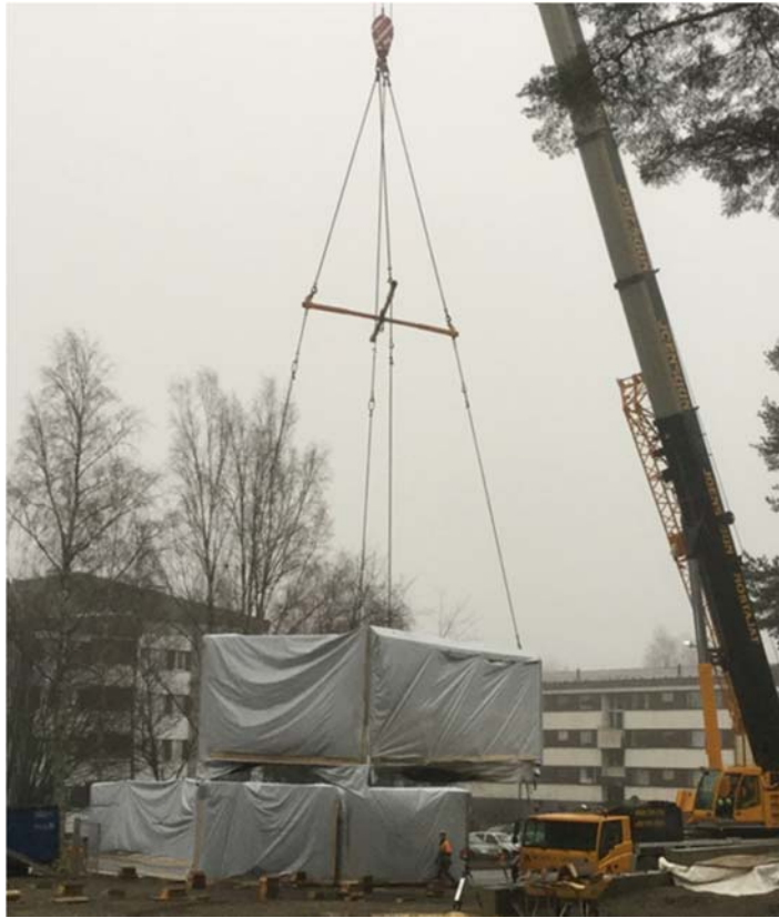
KUVA 8. Suojaustaso 1 mukainen sääsuojaus (Haaranen 2016.)
