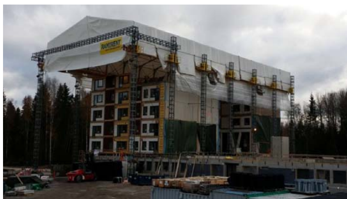
KUVA 35. PuuMera kohteen sääsuojaus (PuuMera 2016a.)
