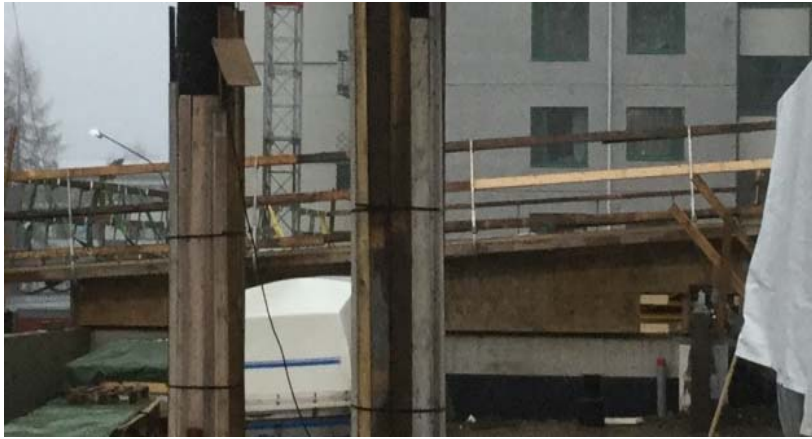
KUVA 13. Väliaikainen sääsuojaus kattoelementti Joensuun pihapetäjän työmaalla (Haaranen 2016.)
