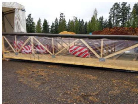
KUVA 37. Puumeran yläpohjaelementti. (PuuMera 2016a.)
