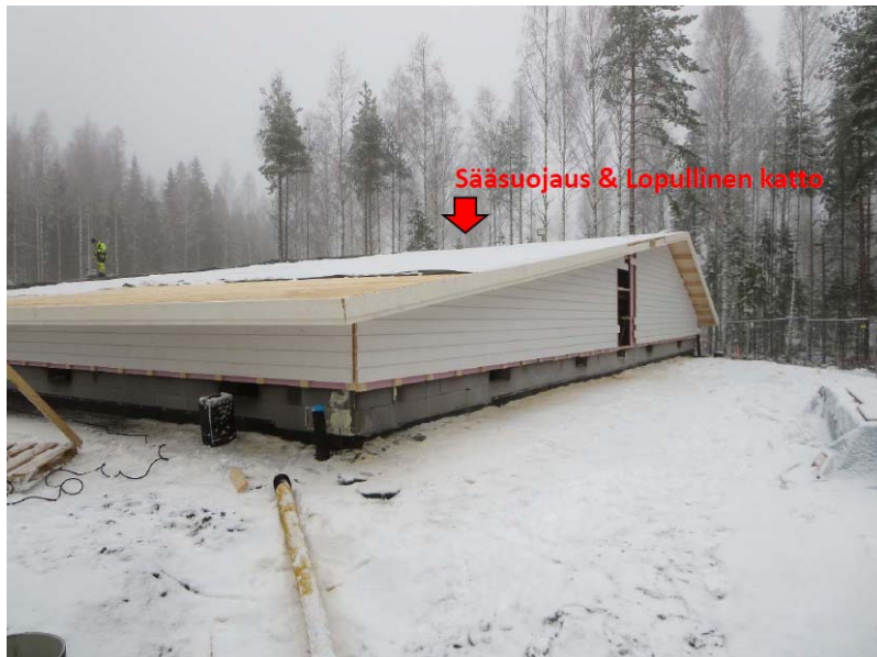
KUVA 14. Lopullinen vesikattoelementti (Puuinfo 2017b, 20.)
