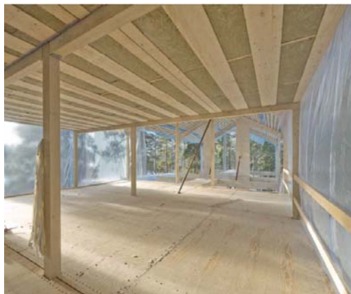
KUVA 18. Runkotöiltä valmis kerrostaso pilari-palkkirunkoisessa kerrostalossa (Puuinfo 2017b, 22.)
