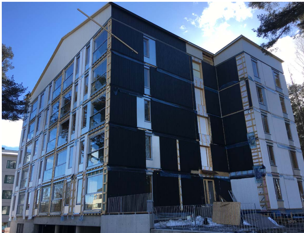
KUVA 41. Joensuun Pihapetäjän työmaa (Haaranen 2017c.)
