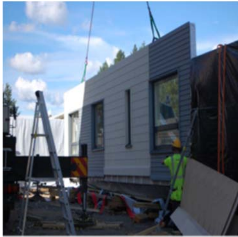
KUVA 20. CLT rakenteisen suurelementin asennus (Elementti Sampo 2016.)
