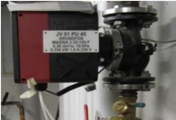
KUVA 6 Kiertopumppu
