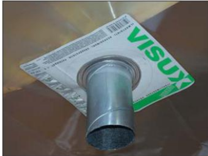
Kuva 31. Ilmastointiputken läpivienti höyrynsulkumuovissa [30].
