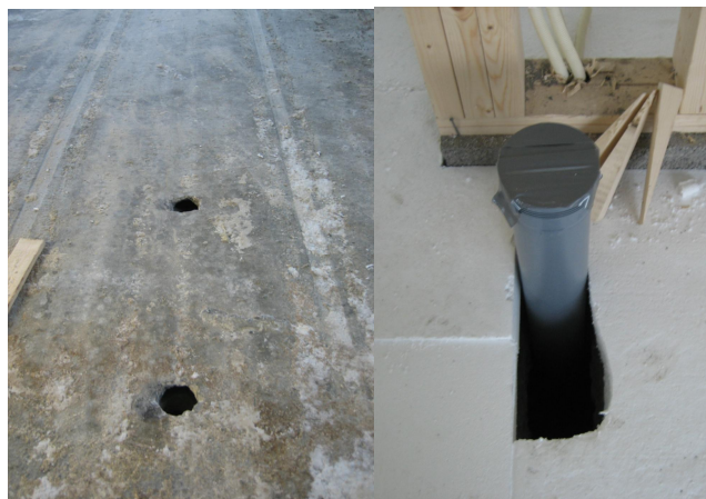
Kuva 32. Putken läpivienti alapohjan läpi. Ensin reikä ontelolaatassa (vas.), sitten EPS-eristyskerros 200 mm (oik.). Kuvasarjasta puuttuu vielä pintabetonilaatta 80 mm.
