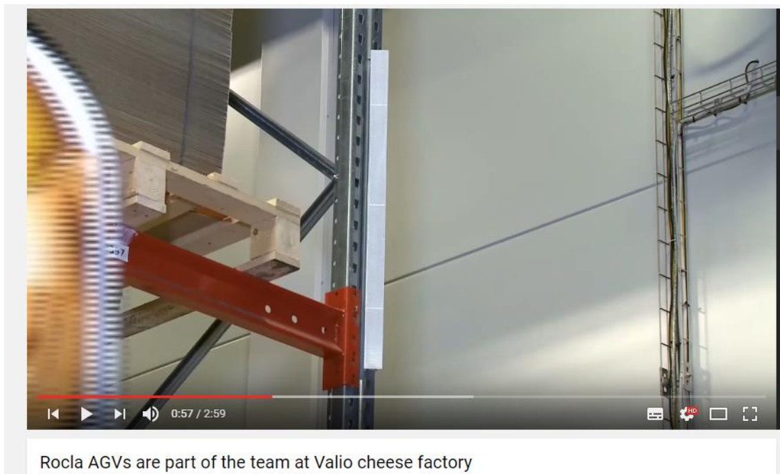
Kuva 7. Heijastinpaneeli asennettuna kuormalavahyllystön palkkiin Valion tehtaalla (Rocla Oy 2016).
