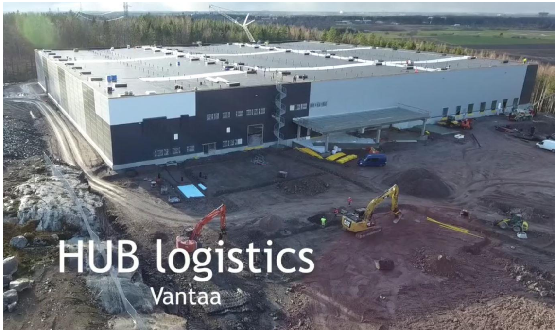
Kuva 16. Hakkilan logistiikkakeskus lokakuussa 2016. Kuvakaappaus otettu HUB logistics Oy:n Vimeon sivuilta (Elfhill Oy 2016).
