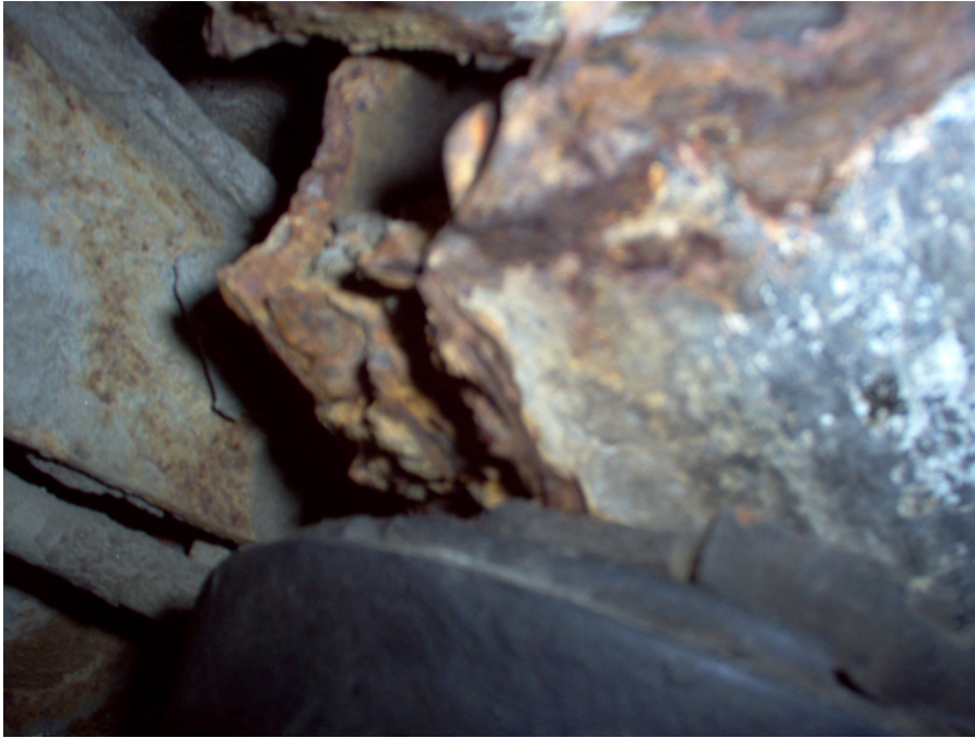
KUVIO 57. Korroosio vaurio apukuljettajan puolelta takarenaan edestä.
