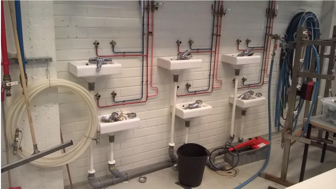
KUVA 20 Kylmävesiverkoston kalusteet on poistettu ja hanakulmat tulpattu.
