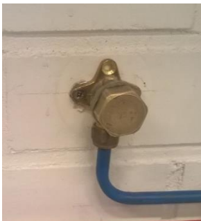
KUVA 18 Hatu laitettuna kylmävesiverkoston pintakulmaliittimen päälle
