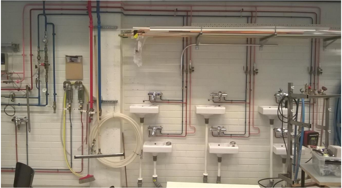
KUVA 14 Laboratorion KV-verkosto
