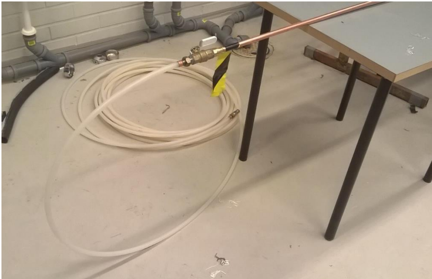
KUVA 28 Muoviputki liitettynä Cu15-testausputkeen
