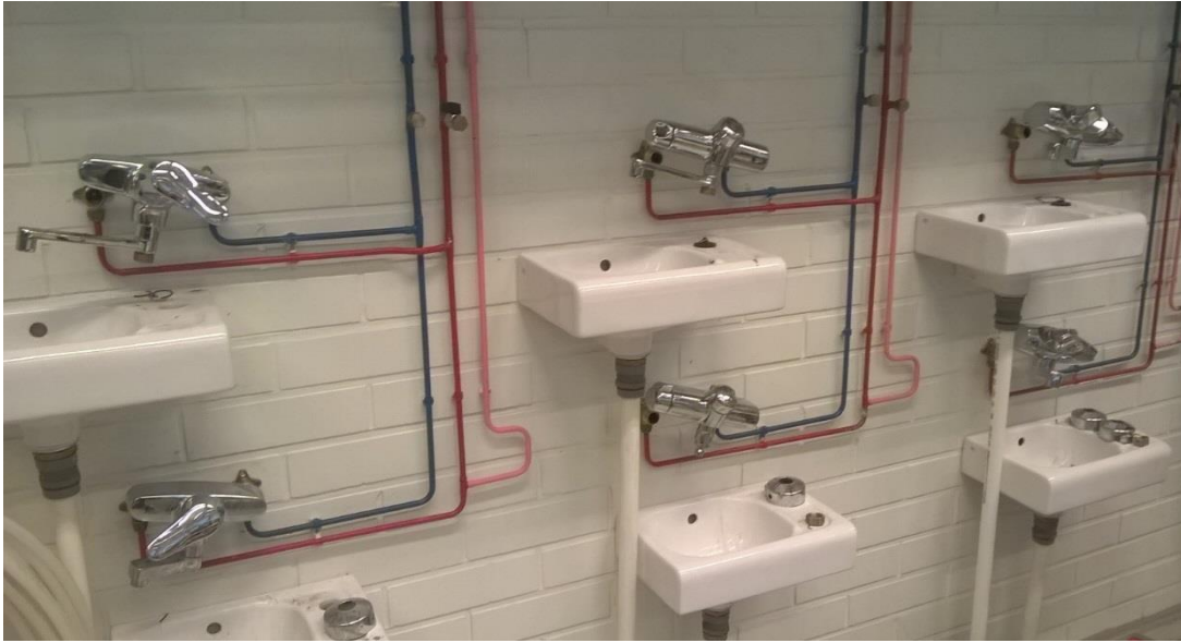
KUVA 22 Hanojen ristivirtauksen vuototesti
