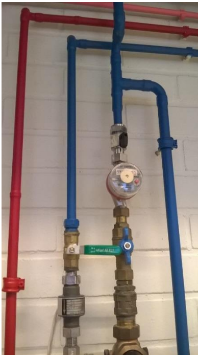
KUVA 15 Kylmänvesiverkoston pääsulkuventtiili
