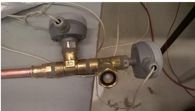
KUVA 25 Yksisuuntaventtiili Hela 381 liitettynä Cu15-testausputkeen
