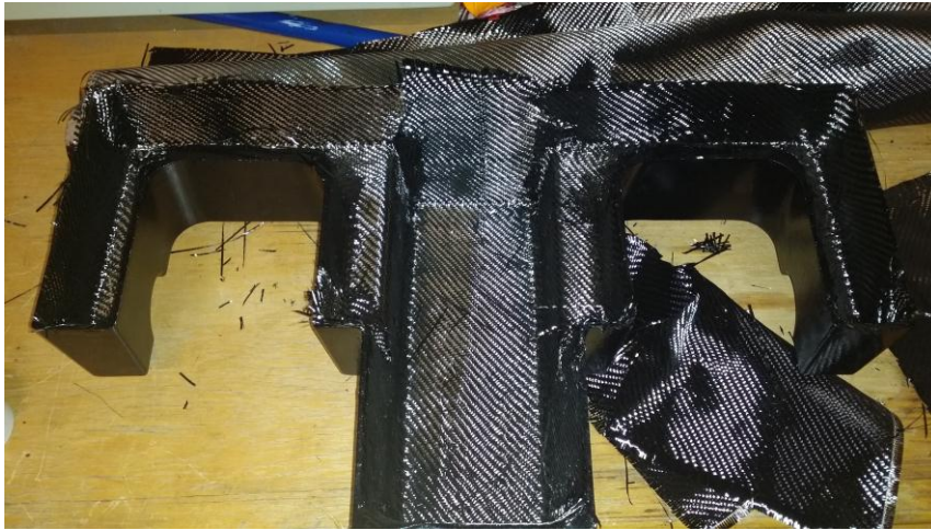
Kuva 5. Hiilikuitulujitteiden asettelu muottiin
