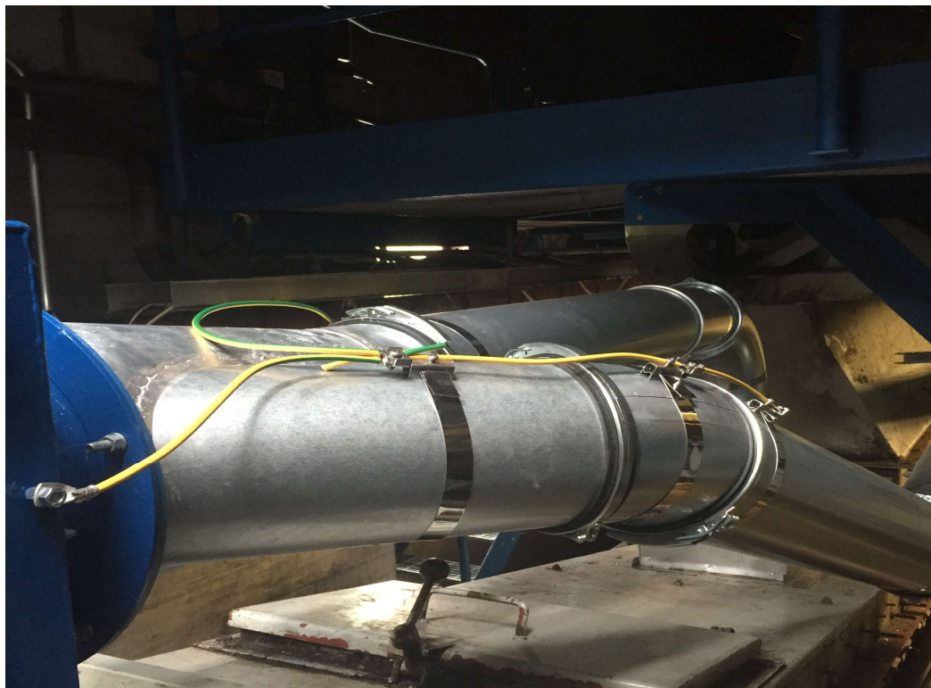
Kuva 10. Putkistolinjan maadoittaminen.
