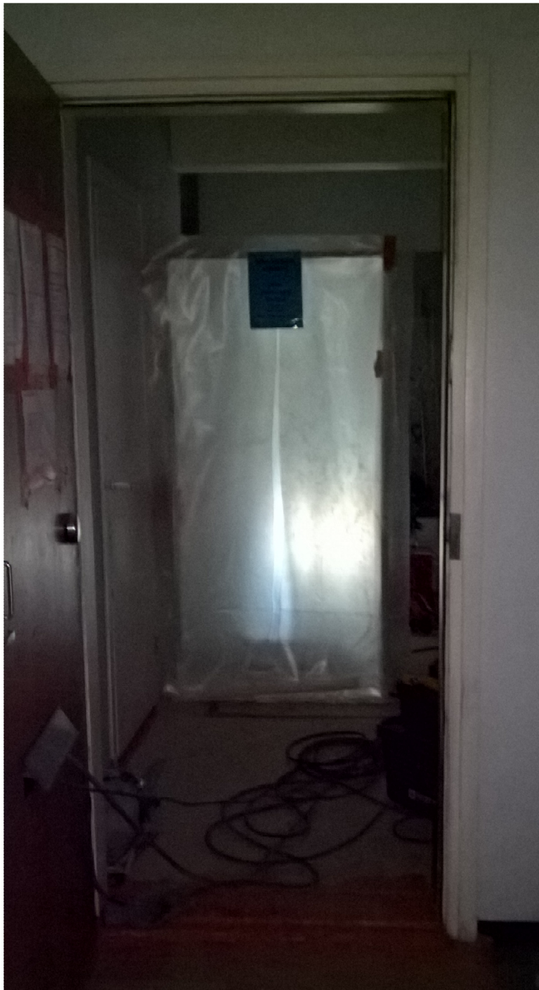
KUVA 2. Asbestipurkualueen kolmisulkuinen sisäänkäynti asunnon eteisessä. 2.8.2017
