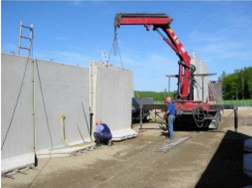
Kuva 1. L- mallinen laakasiilo. (Laakasiilot [Viitattu 17.2.2010.]
