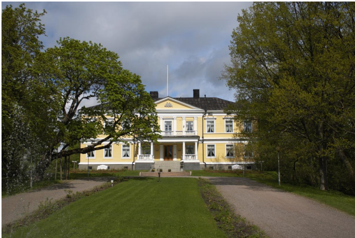
Figur 2. Herrgårdsbyggnaden på Sannäs Gård.
