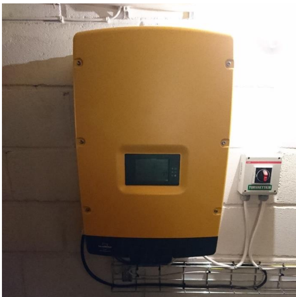
Kuva 6. SB 5000 TL-20 (SunClix) invertteri.
