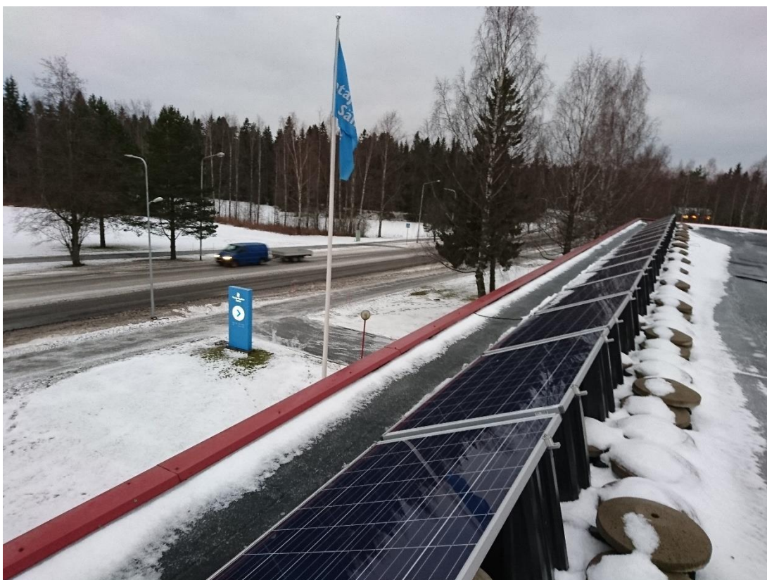
Kuva 9. Paneeleita varjostaa lipputanko, koivu ja kuusi.
