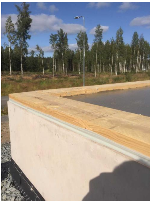
Kuva 10. Alapuun ja sokkelin välinen kitattu liitos
