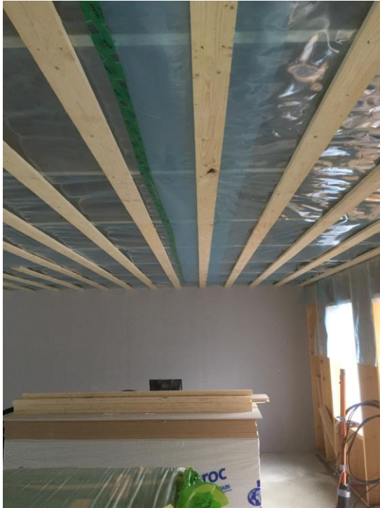
Kuva 14. Höyrynsulkumuovin limittäminen ja teippaaminen yläpohjassa
