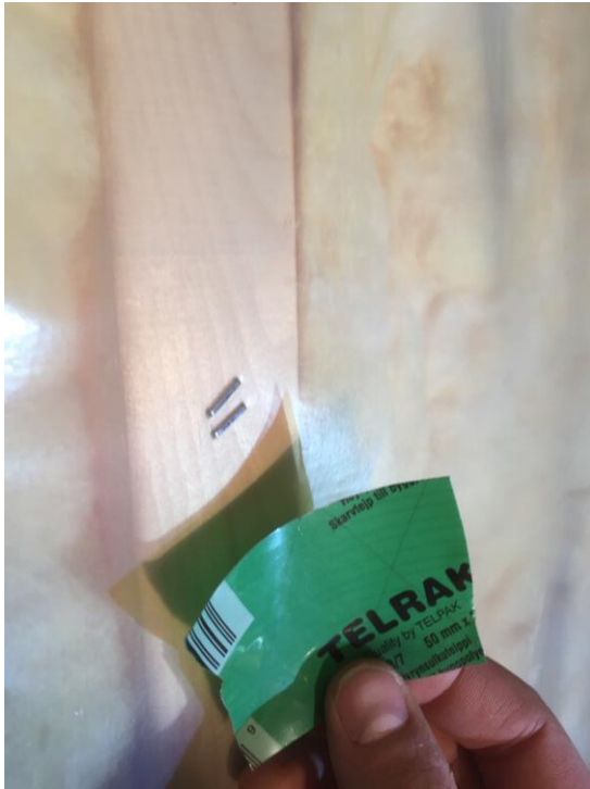
Kuva 12. Kiinnitysreiän tiivistäminen teippaamalla
