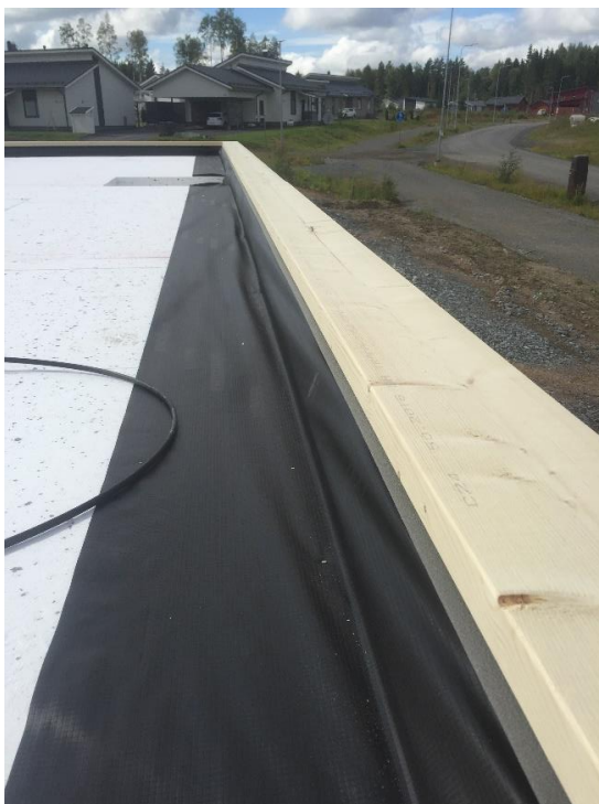
Kuva 9. Radonkaista asennettuna viistetyin eristeen päälle ja solumuovieriste alapuun alla
