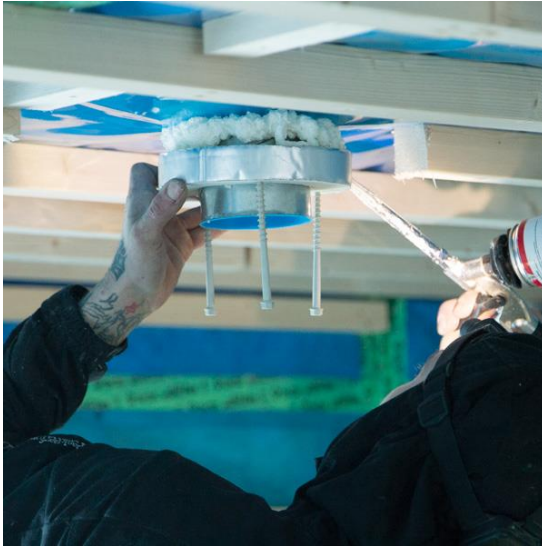
Kuva 19. Ilmastointiputken läpiviennin tiivistys vaahdottamalla (BetterPipe www-sivut 2017)
