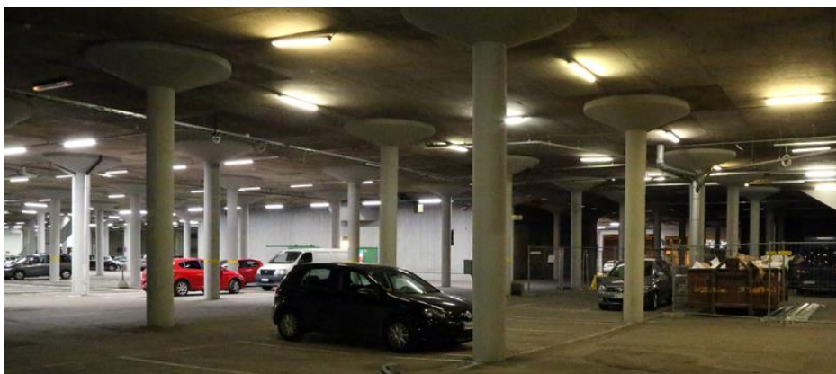
Kuva 16. Helsingin Merihaan parkkihallin vanhoja loisteputkivalaisimia korvataan LED-valaisimilla [42].
