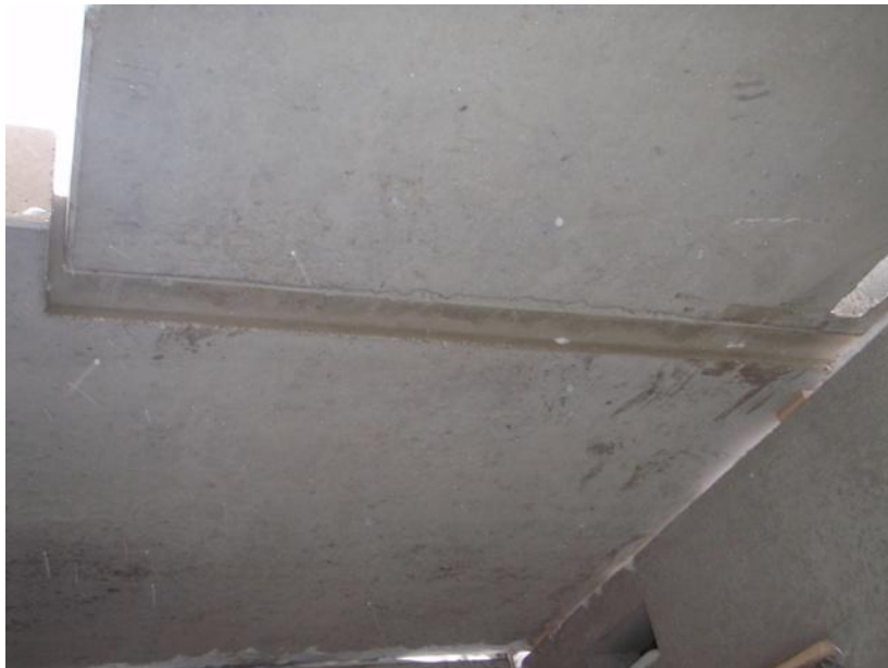
Kuva 2. Varaus laatan alapinnassa
