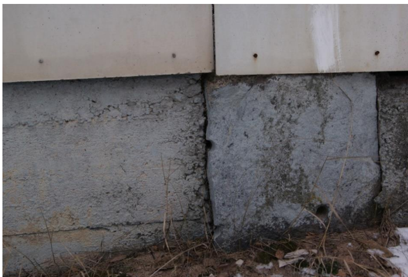
Kuva 6. Umpeen valettu sokkeli, jossa ei tuuletusaukkoja (Eerola Hanna 2017-02-21)
