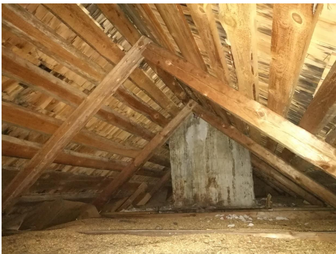
Kuva 9. Yläpohja (Eerola Hanna 2017-02-21)
