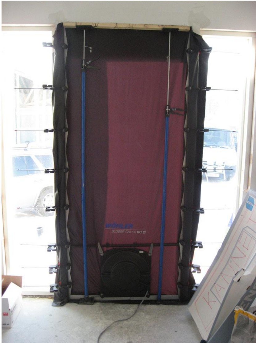
Kuvio 8. Paineekoelaitteiston asennus oviaukkoon.
