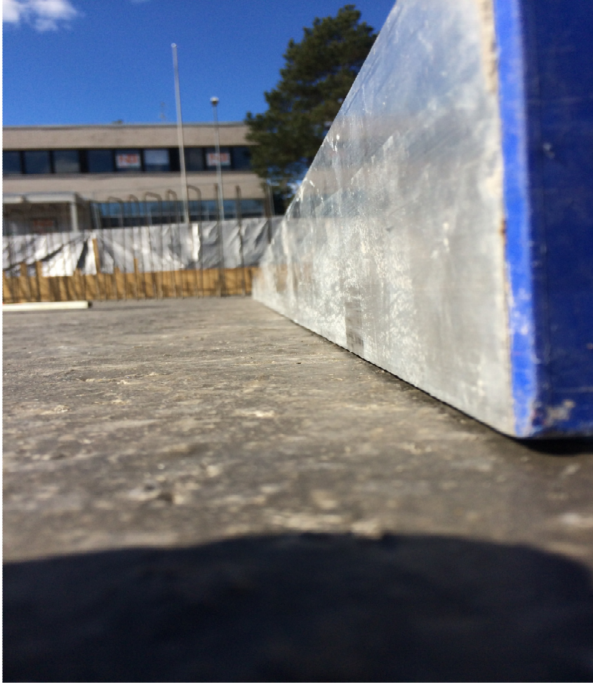
Kuva 5. Lattian suoruuden tarkastelua 3000 mm linjarilla. Kuvassa täysin suora pinta.
