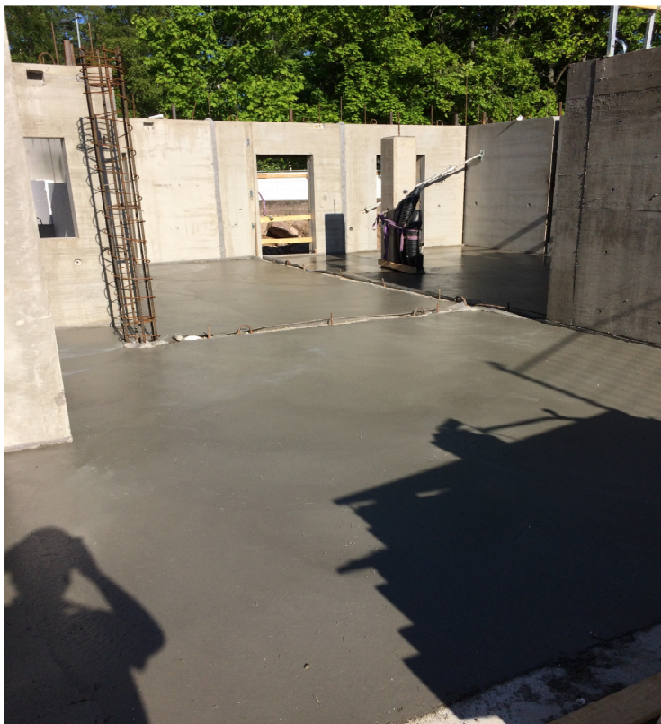
Kuva 13, Maanvarainen laatta teräshierron jälkeen.
