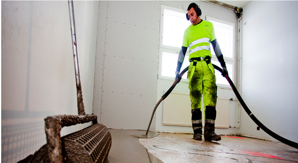
Kuva 7, Lattian tasoittamista pumppaamalla [6.]
