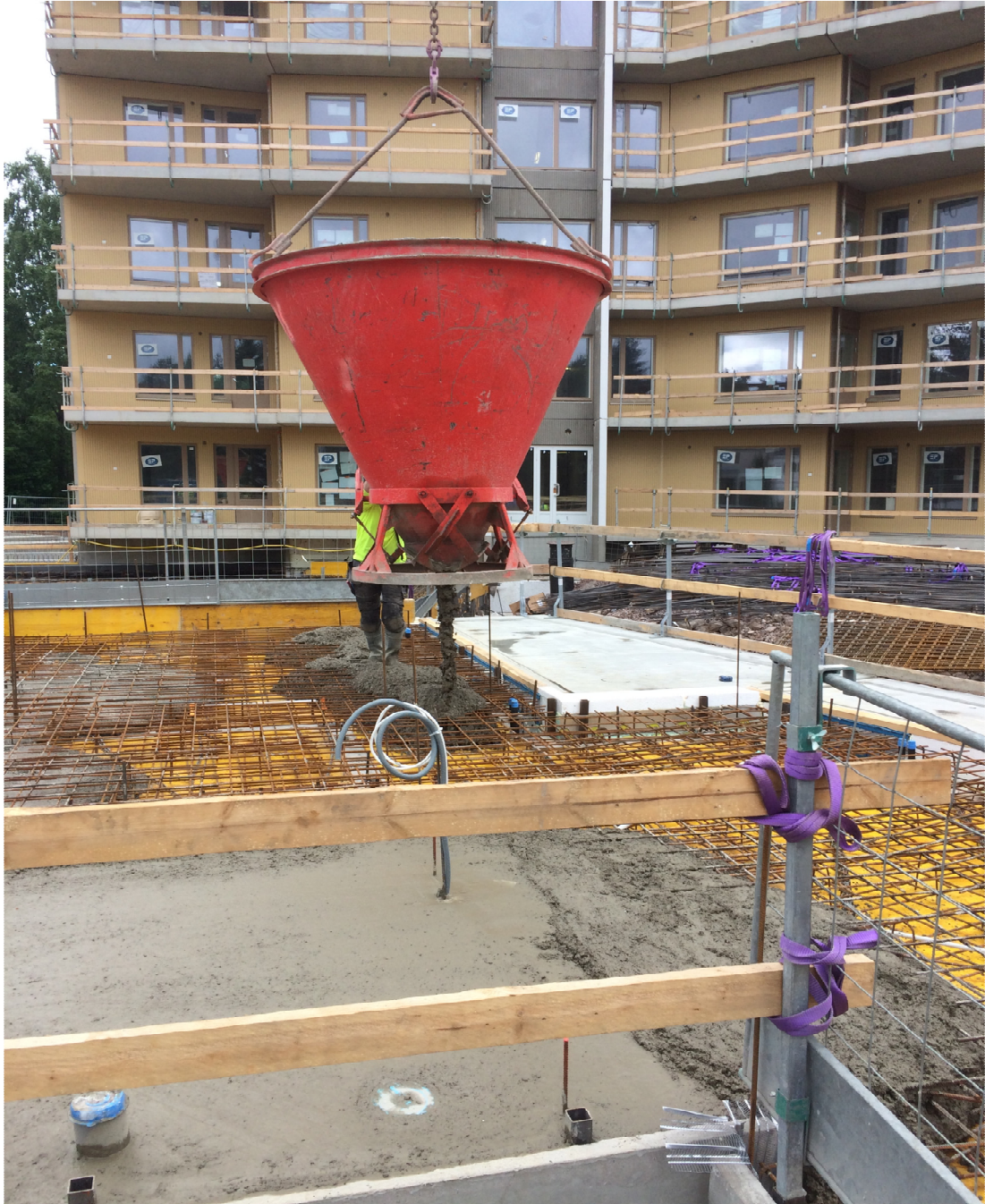
Kuva 3, Paikallavalettavan välipohjan valutyö nostoastialla.
