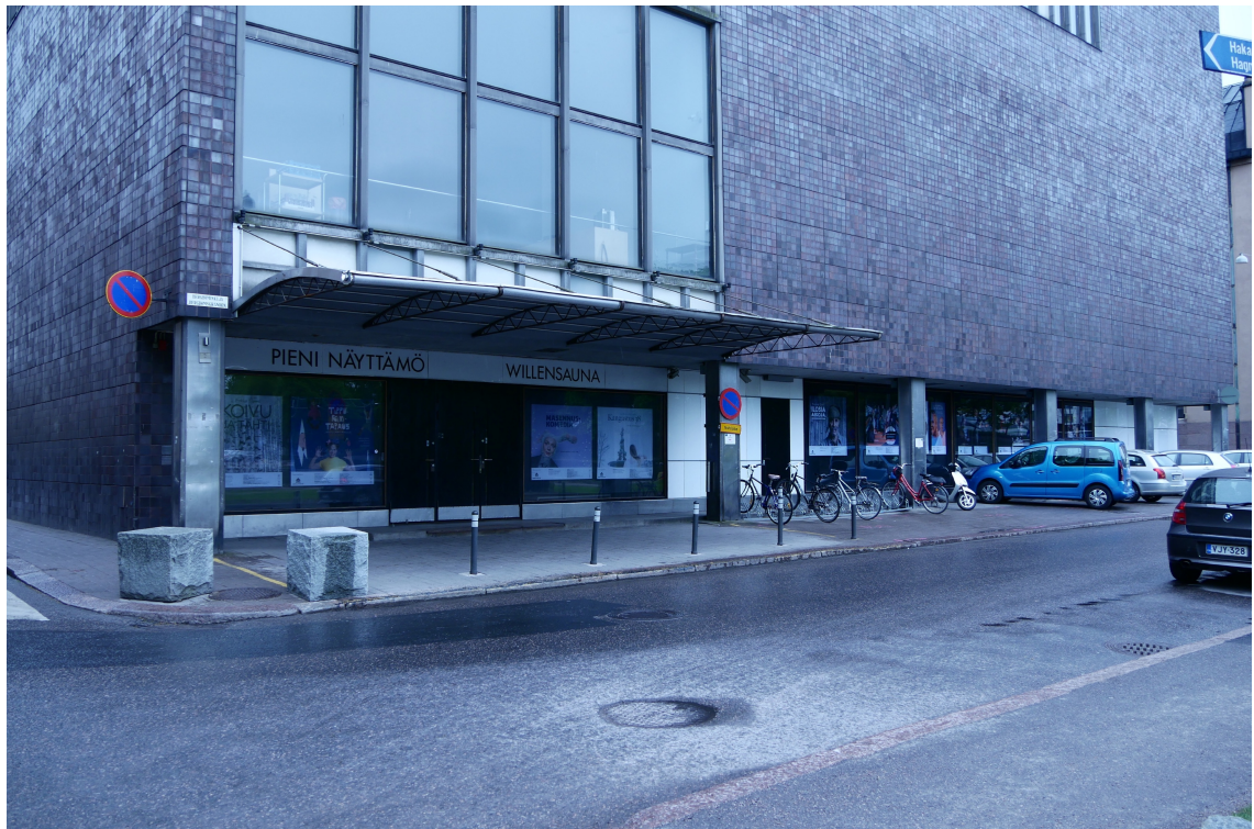
Kuva 6. Willensaunan sisäänkäynti Kaisaniemenpuiston puolelta. (Koivuniemi 2017.)
