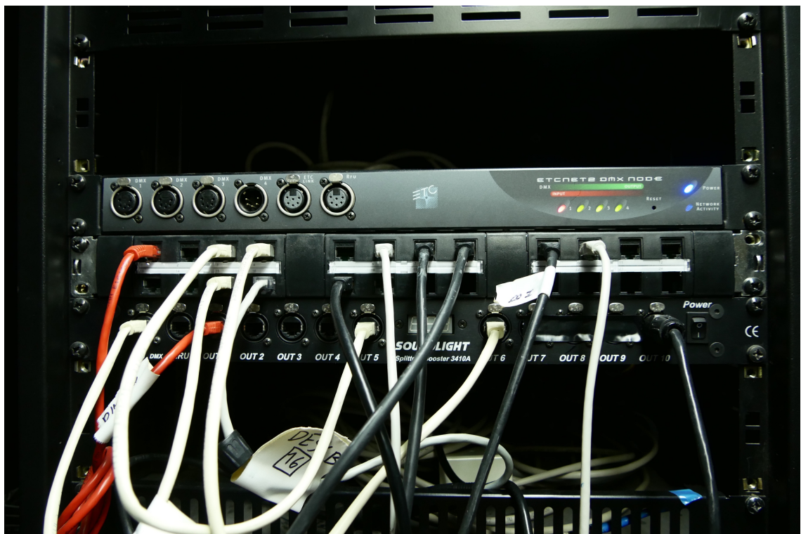
Kuva 17. DMX-verkon ristikytkentäpaneeli sekä DMX-splitteri (Koivuniemi 2017.)
