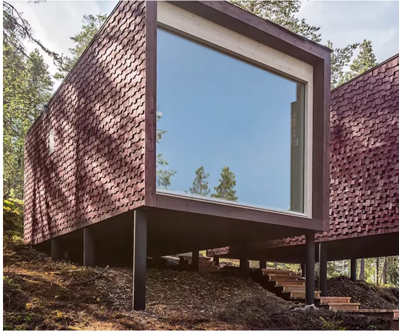
Kuvio 1. Rinteessä pilareilla seisova rakennus. Taustalla oikealla puolen näkyy toinen vastaavanlainen ja keskellä näiden välinen kulkuportaikko sisäänkäyntitasoon. (SantaPark Arctic World 2017)
