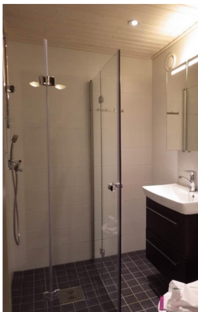
Kuva 2. Esimerkki perinteisen putkiremontin yhteydessä saneeratusta märkätilasta [2, s. 7.]
