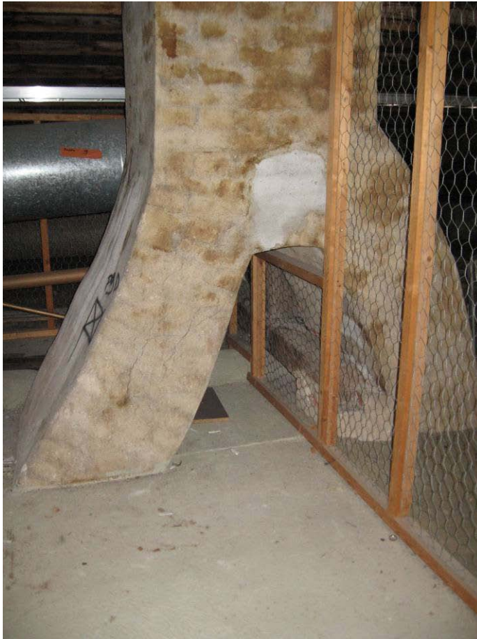
KUVA 8. Hormit yhdistyvät yhdeksi piipuksi D14 ullakkotiloissa. Kuva: Niko Lipponen.
