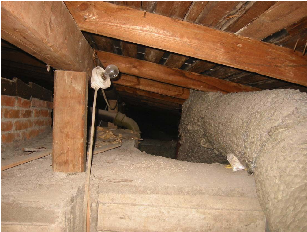
KUVA 7. Metsätalon ullakko ennen peruskorjausta. Kuva: Jukka Sulku.
