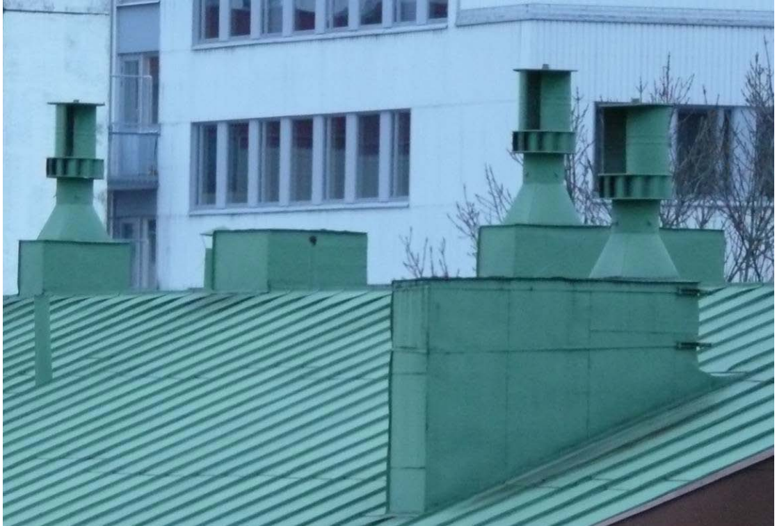
KUVA 2. Savonius-roottoreita talon katolla. Kuva: Tommi Takala.
