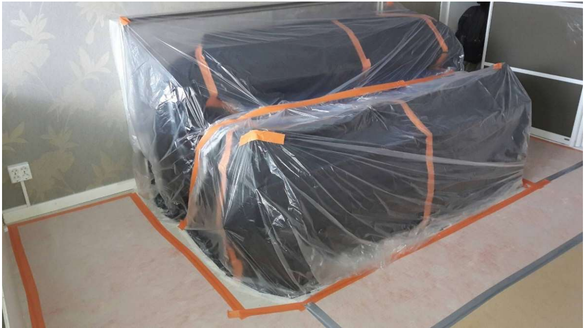
KUVA 2. Huonekalut ja lattia suojattuna lvis-saneerattavan huoneiston makuuhuoneessa (Korolainen 2017)
