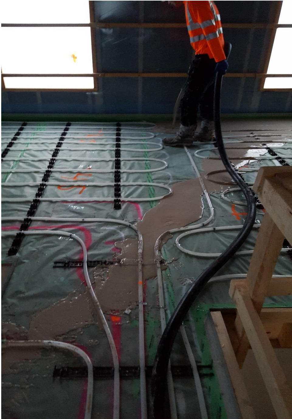
Kuva 6. Kipsivalulattian pumppausta As Oy Helsingin Klementiinissä.
