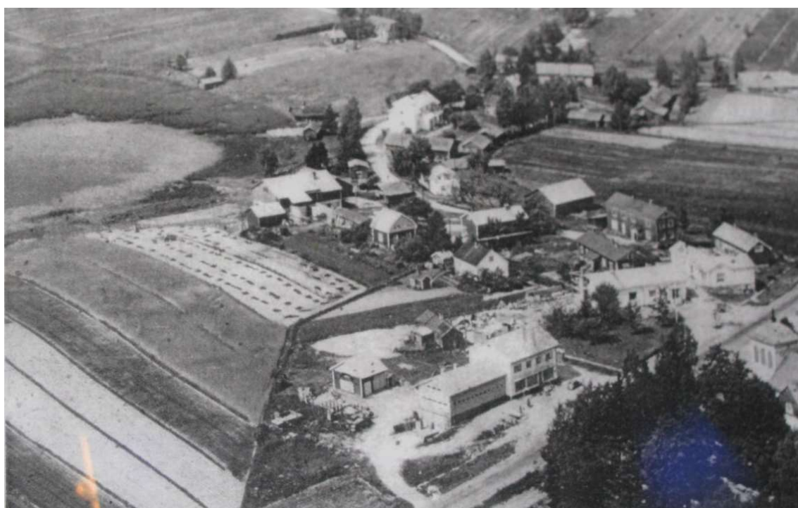
Kuva 23. Eräjärven alueen ilmakuva 1950-luvulta. Alkuperäinen kuva on vanha postikortti, joka on ollut nähtävillä Pub Eräjärven seinällä. (Valokuva: Ympäristösuunnittelu Oy Pirkanmaa 2012.)
