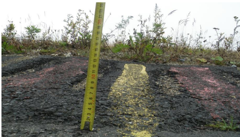
Kuva 6. Kanttareiden mittausta (Manninen 2017-09-28)
