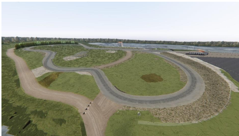
Kuva 29. Ilmakuva etelästä päin kuvattuna. Oikeassa reunassa näkyvät lähtöpaikan rakennukset (Manninen 2017-11-16.)
