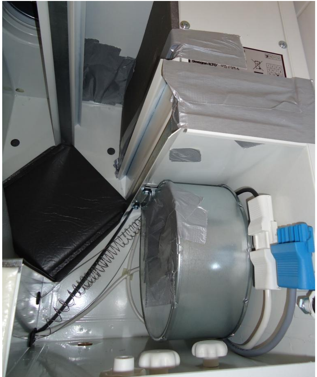
Kuva 13, Svegon ILTO 270 -ilmanvaihtokoneen tiivistys
