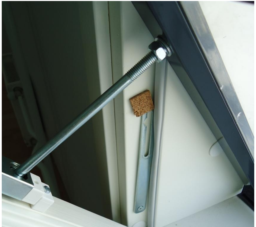
Kuva 17, Asunnon A4 makuuhuoneen tuuletusikkuna
