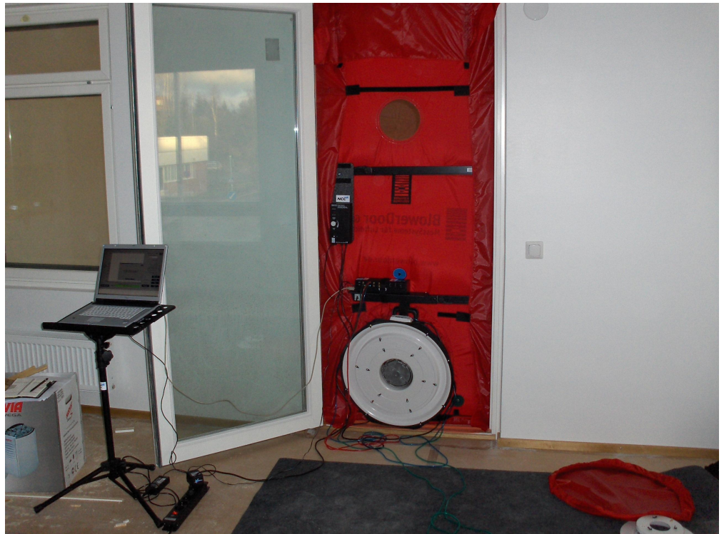
Kuva 10. Alipaineen synnyttävä puhallin ja mittauslaitteisto
