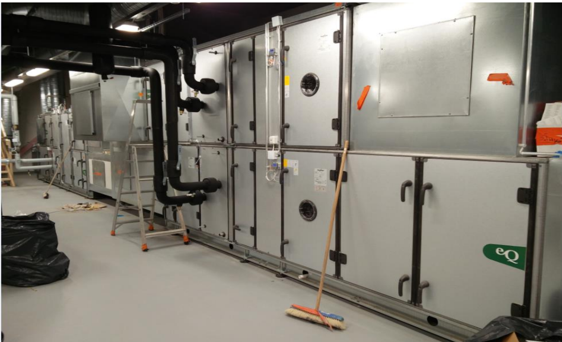
KUVA 37. IV-konehuone ja tulo- ja poistoilmakoneet 202TK ja 201TK
