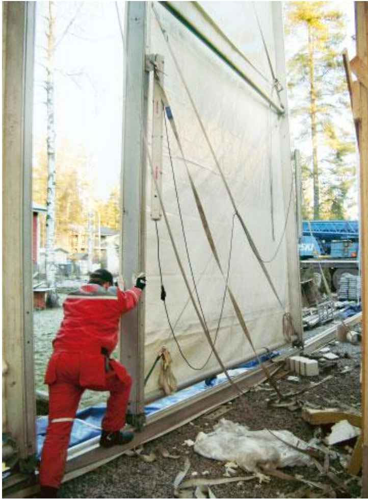
KUVIO 15. Liukukiskoilla perustettu sääsuoja (Mannonen 2007, 56).
