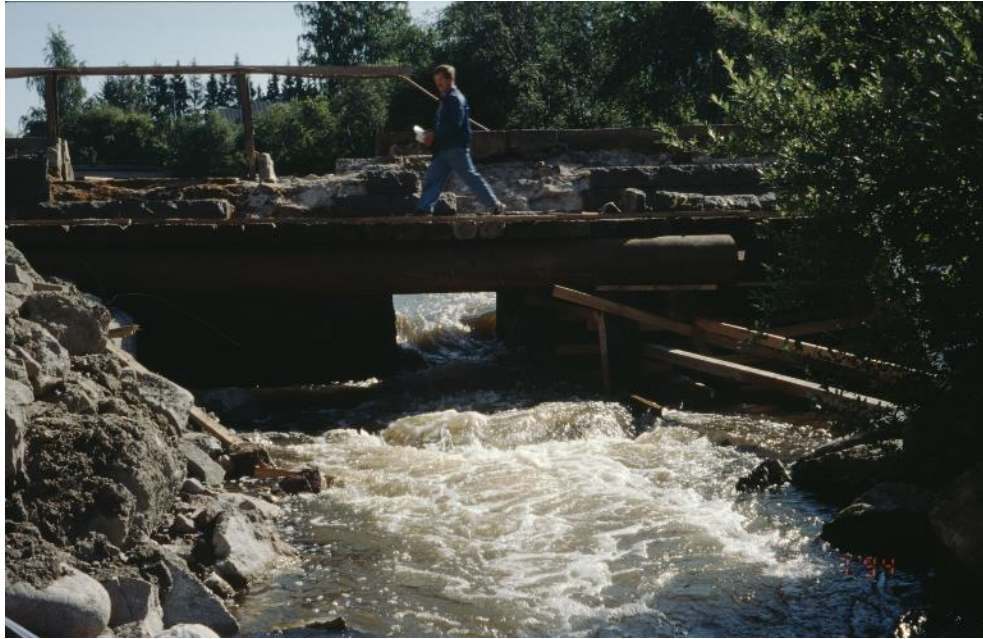
Photo 4. Water flows through the bottom hatch. (Keski-Uudenmaan vesiensuojelun liikelaitoskuntayhtymä 1994.)
