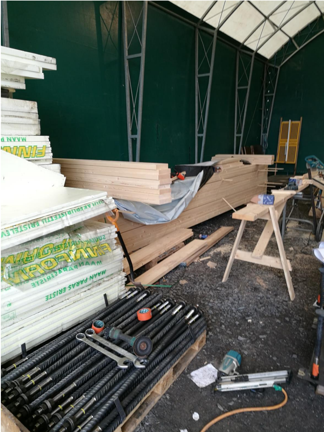
KUVA 4. Työmaan sääsuoja sisältä
