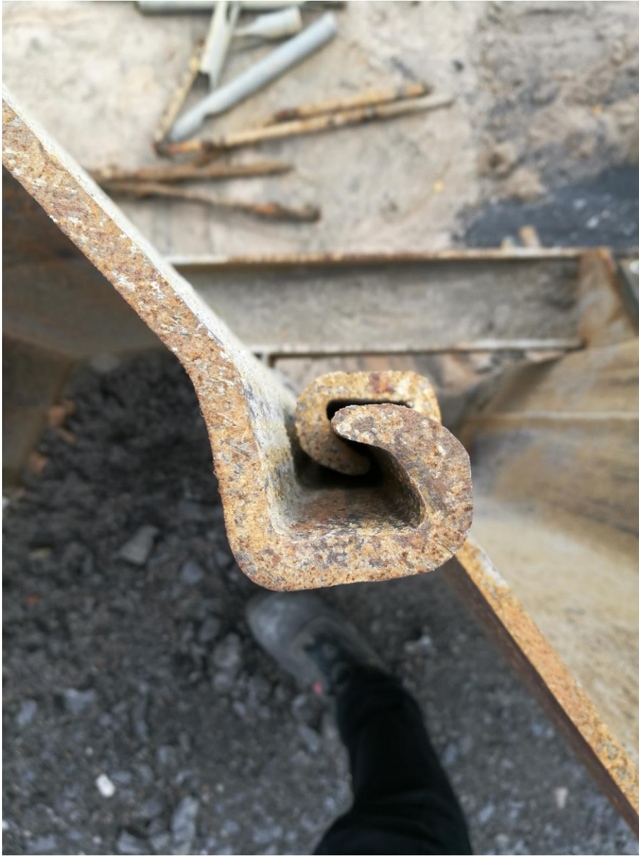
KUVA 1. Teräsponttiseinän ponttiliitos
