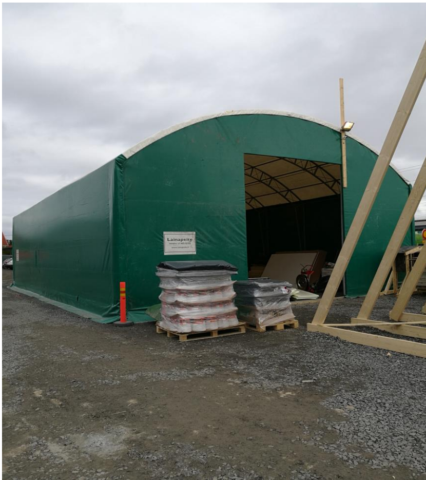
KUVA 3. Asemantornin työmaan sääsuoja
