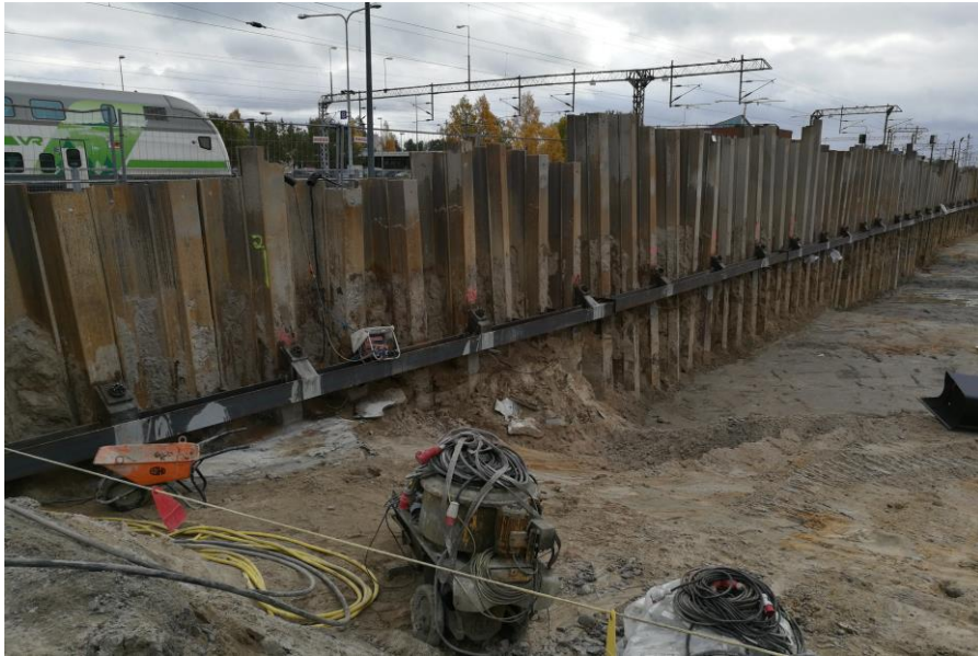
KUVA 2. Kaivanto ja teräsponttiseinä
