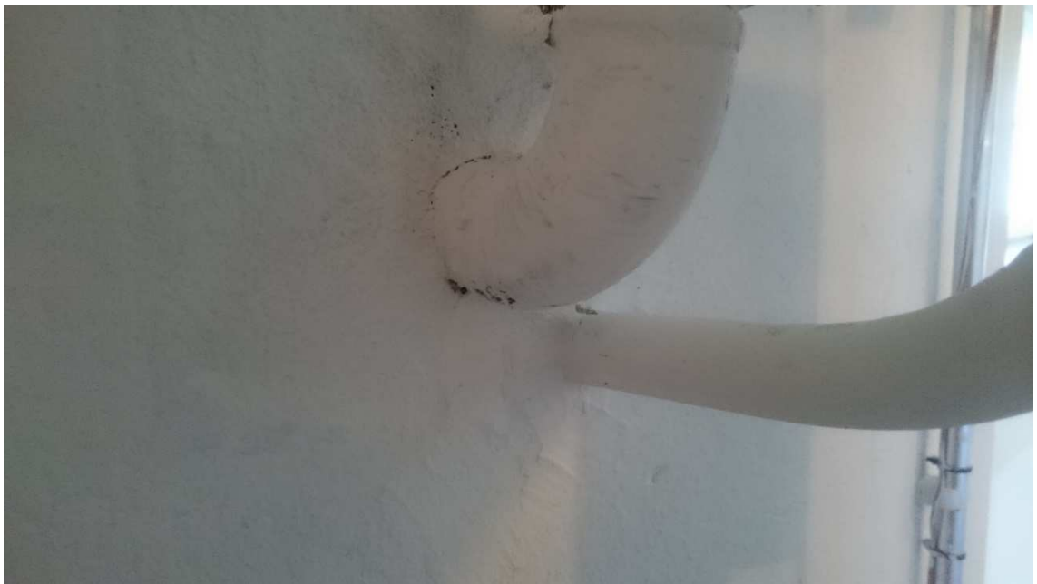
Kuva 14. Vanha vesijohtojenläpivienti
