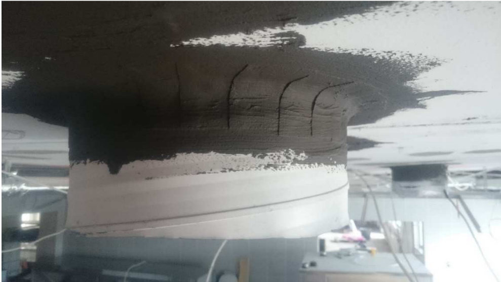
Kuva 10. Ilmastointiläpivienti välikatolle
