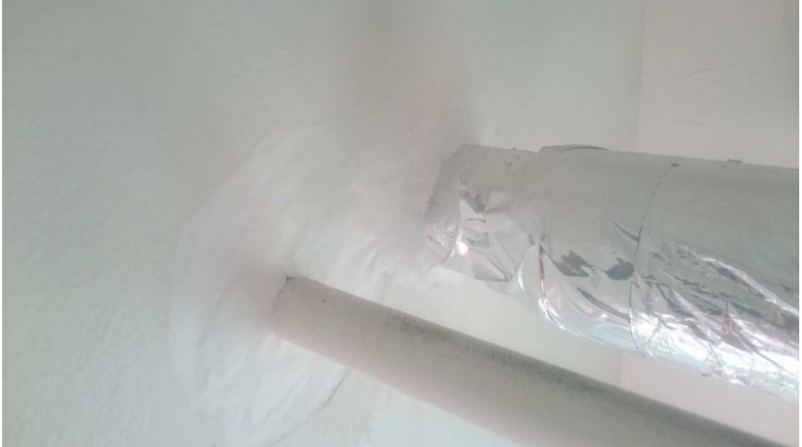
Kuva 1. Patterilinjanputkien läpivienti
