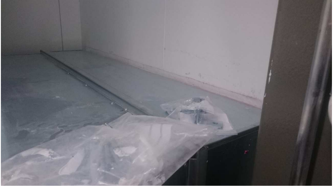
Kuva 22. Kanttisen tuloilmakanavan läpivienti seinän läpi
