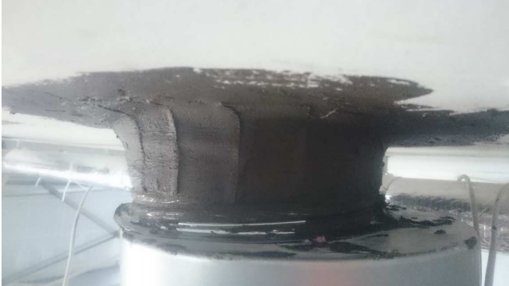
Kuva 9. Ilmastointiläpivienti välikatolle
