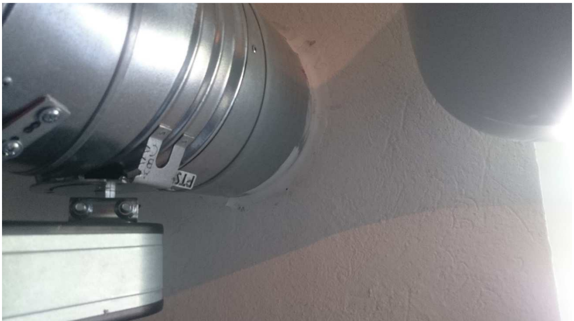
Kuva 13. Ilmanvaihtoputkenläpivienti
