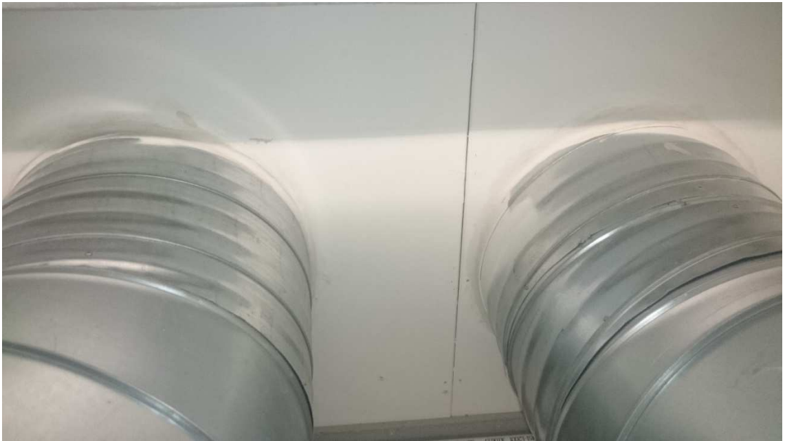
Kuva 21. Putkiläpiviennit seinän läpi
