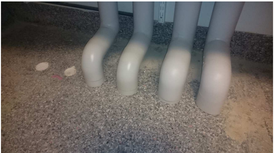
Kuva 5. Vanhat patterilinjaputkienläpivienti
