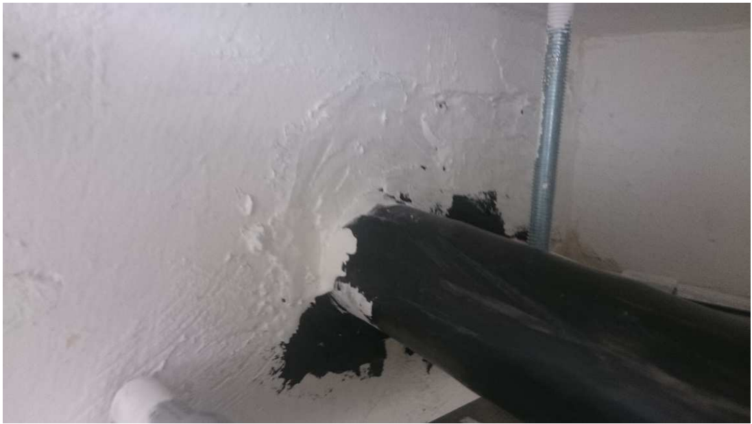
Kuva 17. Pääsyöttökaapelinläpivienti
