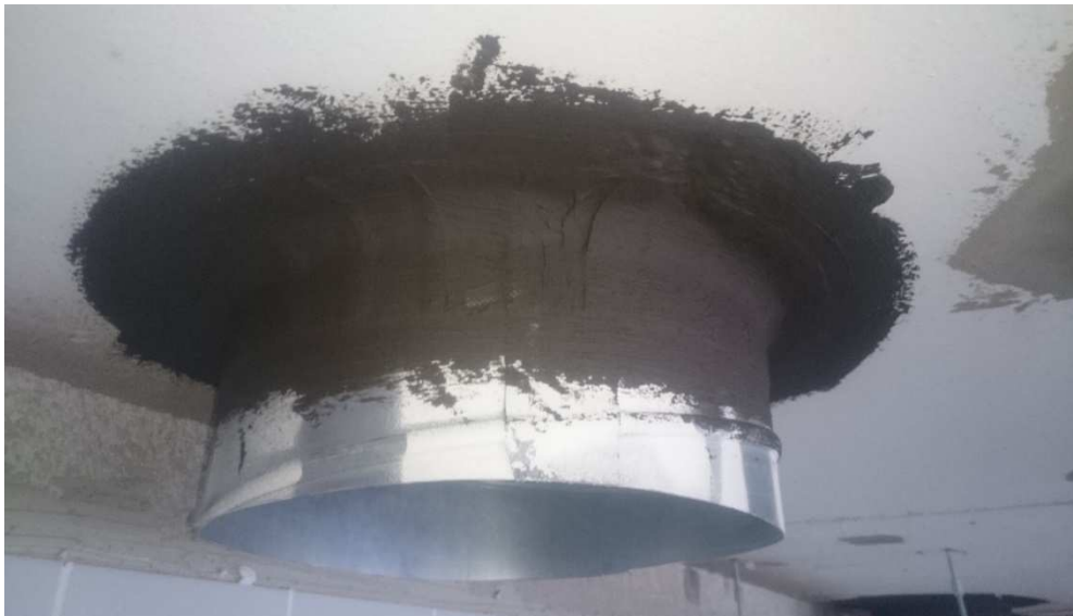
Kuva 8. Ilmastointiläpivienti välikatolle
