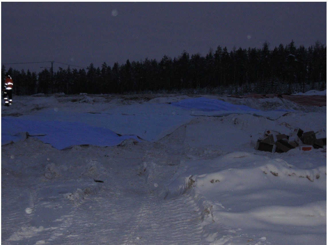
Kuva 3 Kentät peitettiin suojamatoilla
