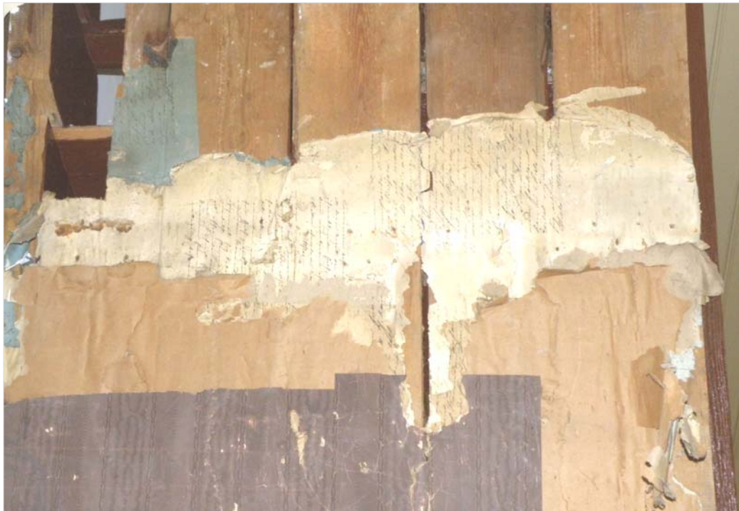
Kuva 19. Keisarinaseman ullakolle johtavien portaiden taustapinta. Portaiden taustalle on liisteröity vanhoja kirjeitä ja venäjänkielisiä sanomalehtiä. Paperien päällä on makulatuuri- ja tapettikerroksia. Portaajat sijaitsevat entisissä asemapäällikön asuintiloissa. Portaajat siirrettiin asemarakennukseen keväällä 2009 puretusta Hinkkasen talosta, Lappeenrannan keskustasta. Hinkkasen talo on valmistunut vuonna 1852 ja puinen lisäosa vuonna 1887 (Kiiveri-Hakkarainen 2006: 17). (Maijanen 2010)
