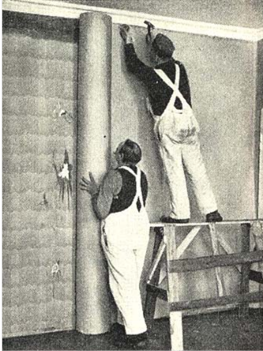
Kuva 20. Ensopahvin asennusta. Pahvirulla kierrettiin seinäpintaan tasaisesti kiristämättä ja naulattiin kiinni ylä- ja alareunoista. (Enso Gutzeit 1930: 19)
