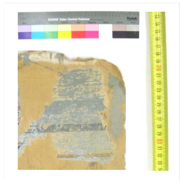
Fragmentti matkatavaratilan vihreästä koristemaalaukerroksesta. Maalaus on todennäköisesti peräisin 1900-luvun vaihteesta. Maalauksen värijako on tyypillisiä viivotusmaalaukselle. Seinän yläreunassa on tumma, ja seinän alareunassa vaaleansävyinen maali. Maalialueita jakaa vieläkin yläosaa tummempi viiva.
