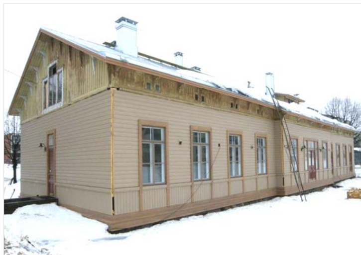
Kuva 5. Asemarakennus keväällä 2010. Yläosan kellertävä panelointi ja valkoiseksi maalatut konsolit ovat osa alkuperäistä julkisivupintaa. (Maijanen 2010)
