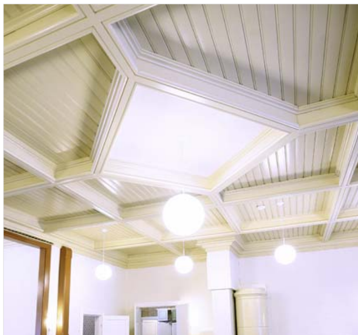
Kuva 12. III-luokan odotussalin rekonstruoitu kattopinta. Kuvaaja: Mika Strandén (Etelä-Saimaan kuvagalleria).
