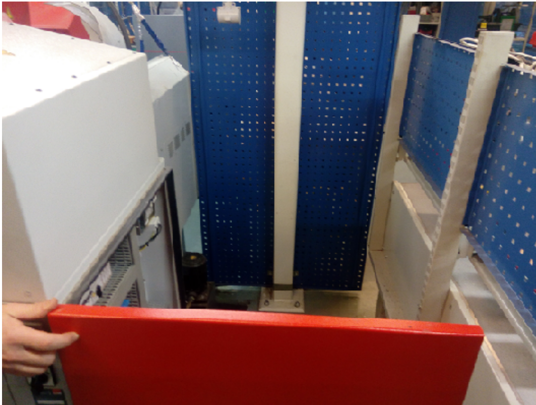
KUVA 14. Riittävästi huoltotilaa koneen takana
