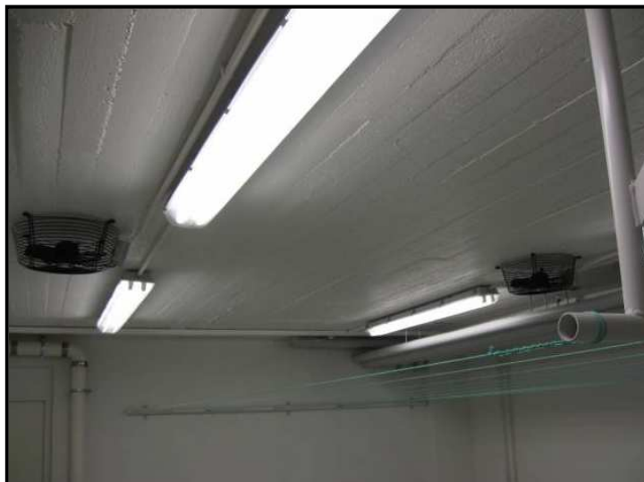
KUVA 16 Pyykkituvan valaistusratkaisu sekä Esterin kattopuhaltimet /12/.
