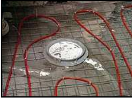
KUVA 12 Lattialämmityskaapeli /12/. KUVA 13 Lattialämmityskaapeli /12/.
