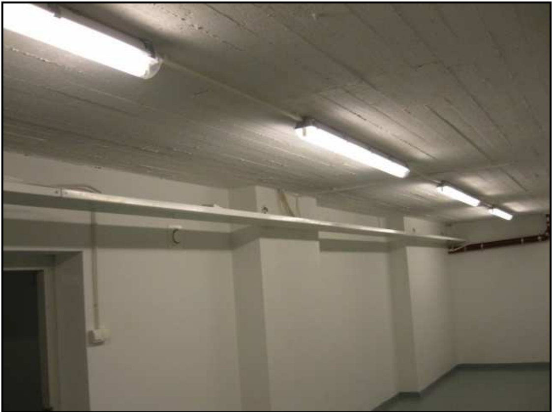
KUVA 2 Varastotilan kaapelihylly- sekä pinta-asennusratkaisu /12/.
