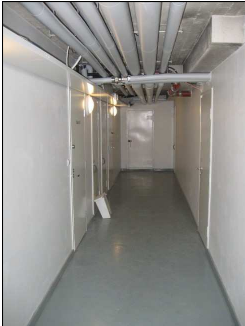
KUVA 4 Kellarin kaapelireittiratkaisu /12/.
