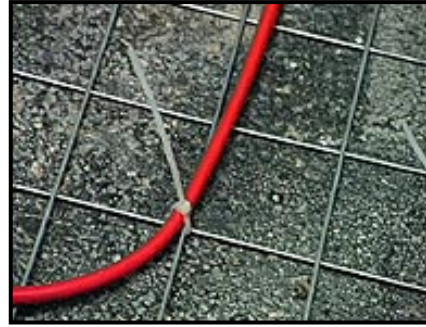
KUVA 12 Lattialämmityskaapeli /12/. KUVA 13 Lattialämmityskaapeli /12/.
