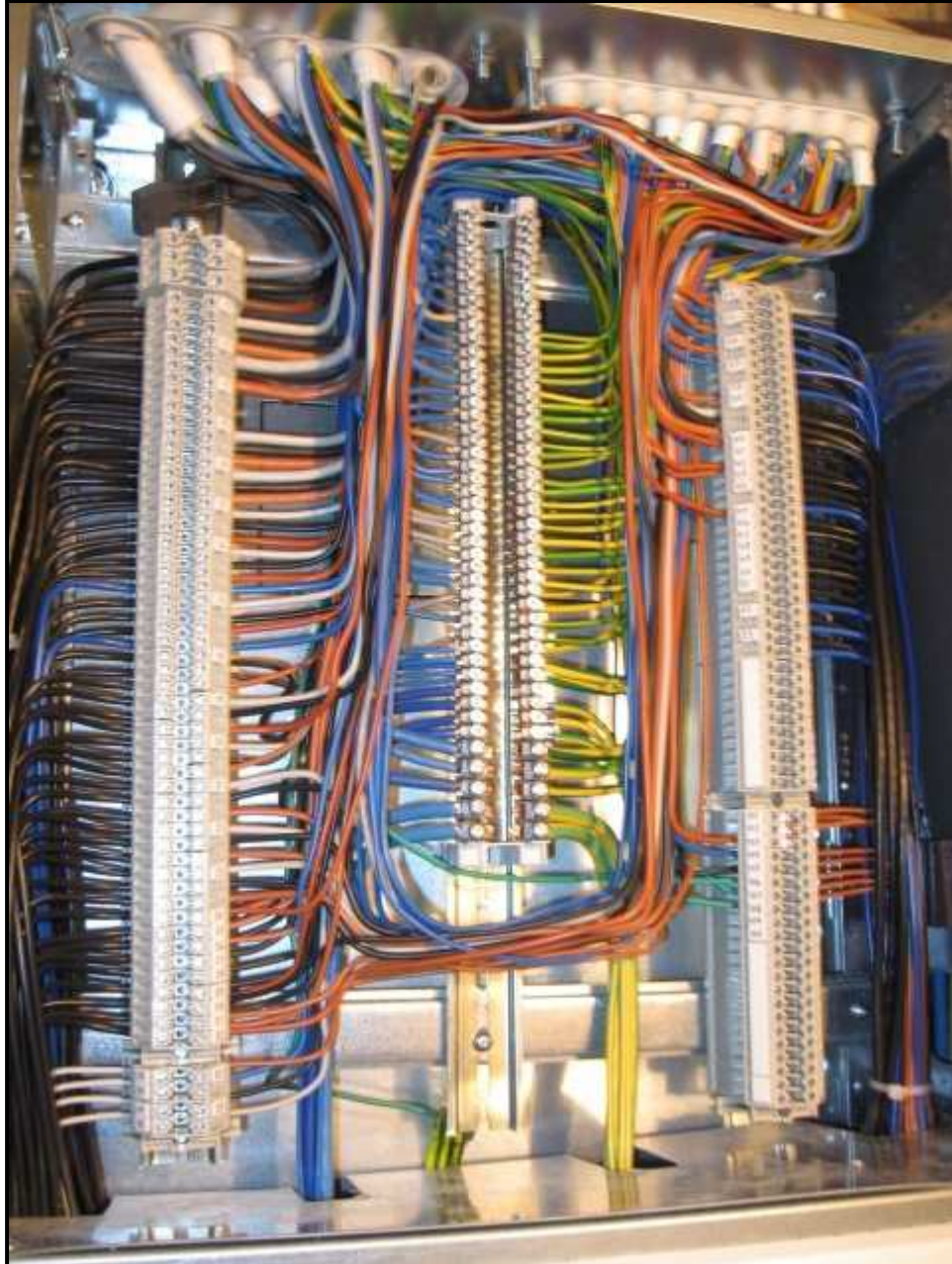
KUVA 15 Pääkeskuksen kytkentärima /12/.
