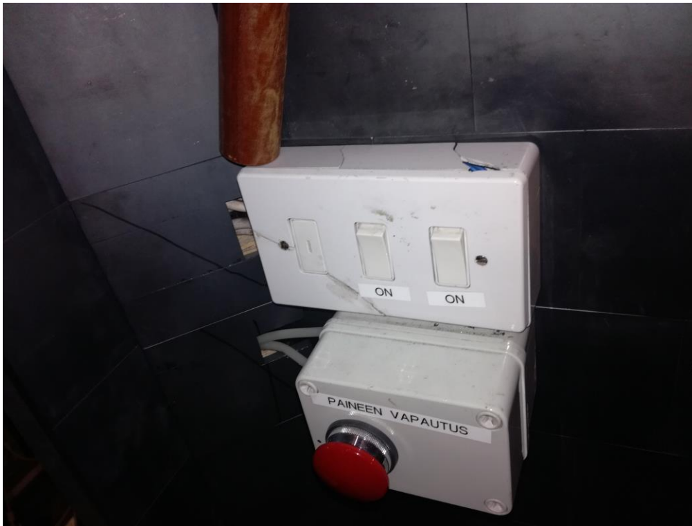
Kuva 3. SAC-testihuoneen valokatkaisin ja ovipaineen vapautuskytkin
