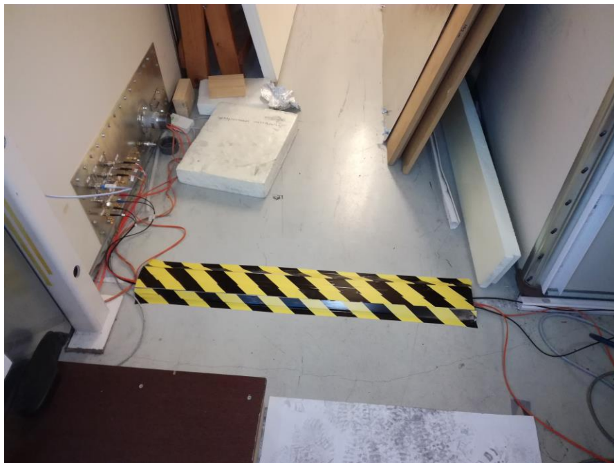
Kuva 7. Valokuitukaapelien suojaaminen kaapelikanavalla
