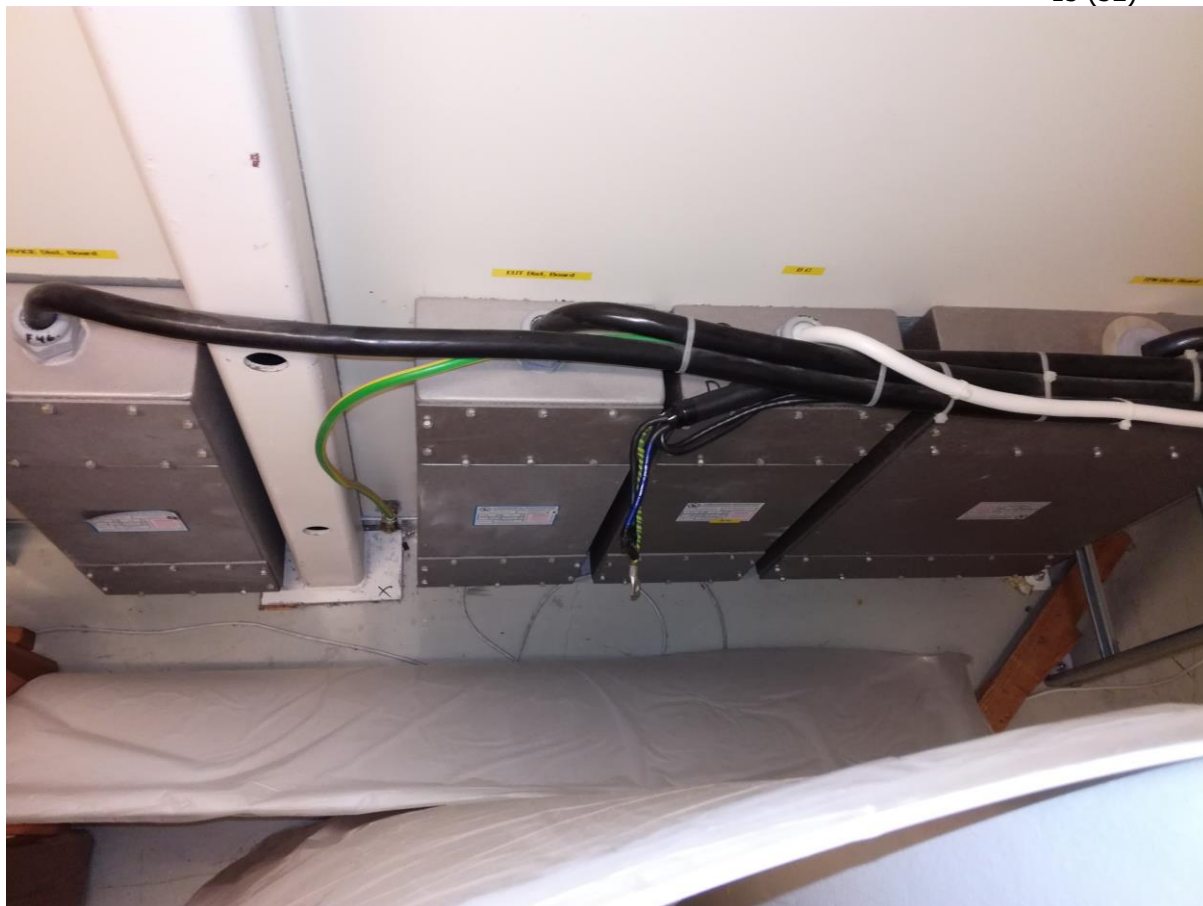
Kuva 2. SAC-testihuoneen ETS-LINDGREN Rayproof EMC-suodattimia
