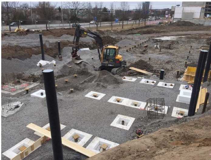
Kuva 8 Pohjalaatan kapillaarikatko ja eristys
