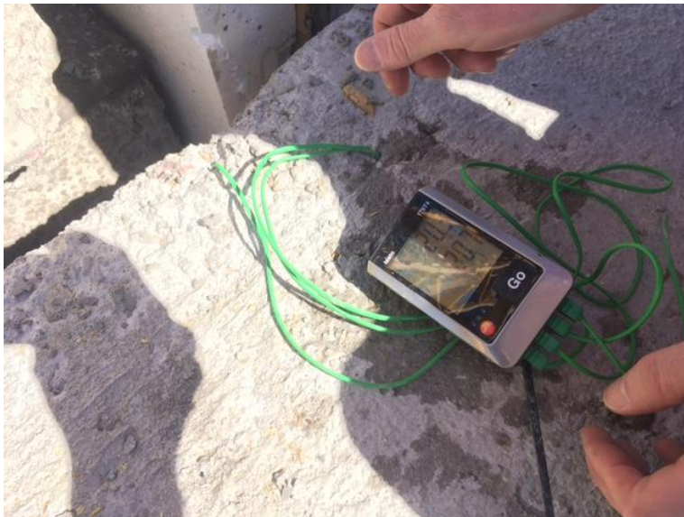
Kuva 11 Betonin lämpötilan seuranta
