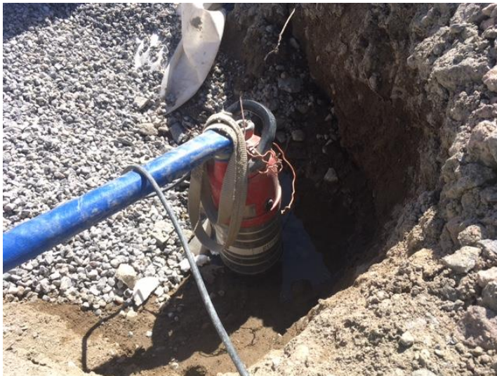
Kuva 10 Maaperän kuivatusta uppopumpulla.
