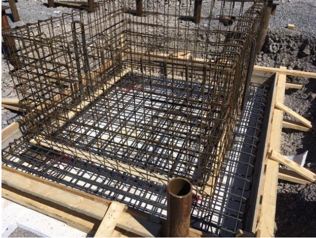
Kuva 6 Hissikuilun pohjan lautamuotti ja raudoitus.
