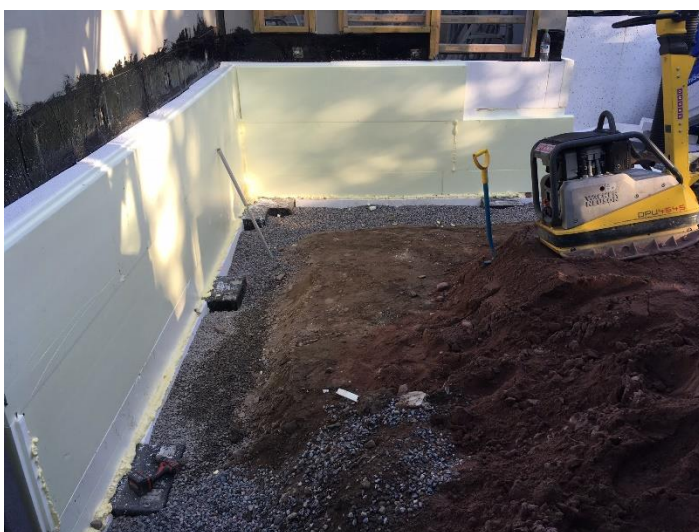
Kuva 9 Kellarin seinän kapilaarikatko ja eristys
