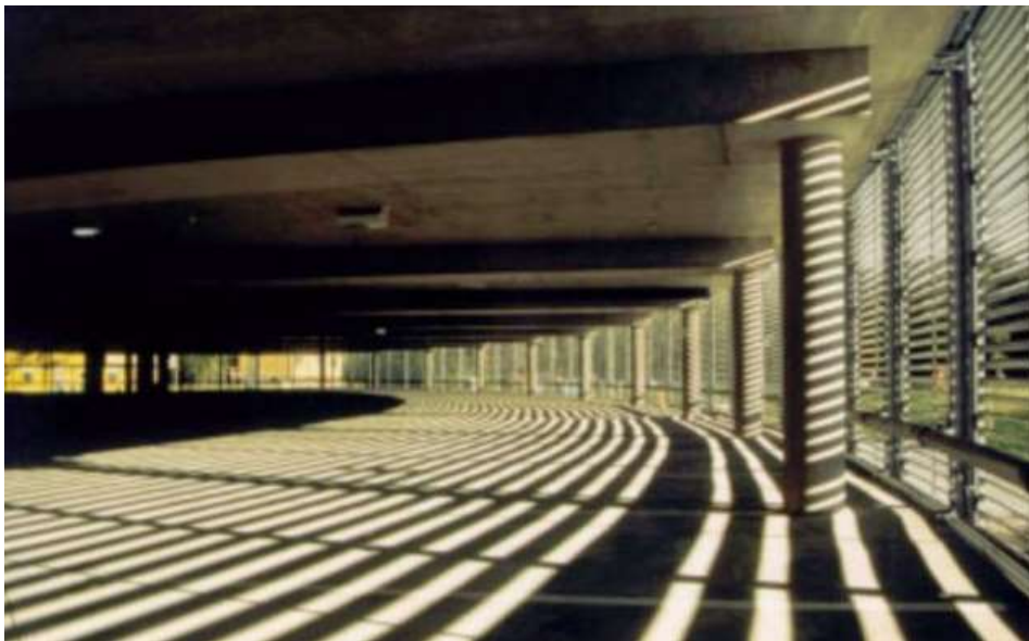
KUVA 4. Jälkijännitettyjä palkkeja parkkihallissa (15, s. 85)
