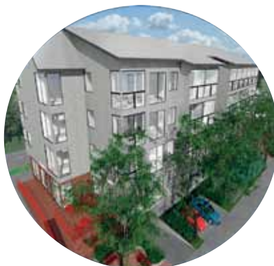
Figure 3. Rajamiehentie nursing home (Elementti Sampo 2017)
